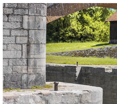
Détail de l'échelle de crue. Phot. Thierry Kuntz IVR26_20172100232NUC4A
