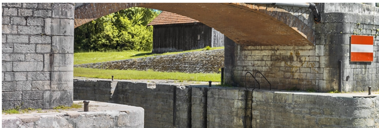
Vue du dessous et des piles : à gauche, l'échelle de crue et à droite, les traces de halage.
