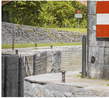
Détail des traces de halage et de la maçonnerie du sas. Phot. Thierry Kuntz IVR26_20172100234NUC4A
