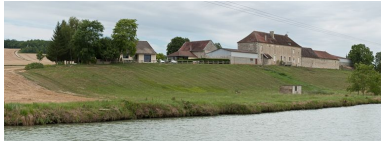
Vue du site depuis le canal. Phot. Pierre-Marie Barbe-Richaud IVR26_20118900352NUC4AQ
