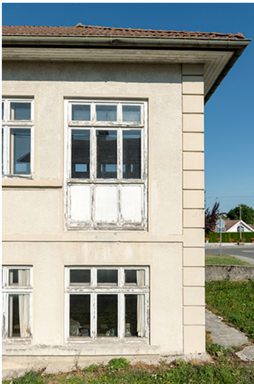
Site d'origine : travée de la façade postérieure de l'usine.
