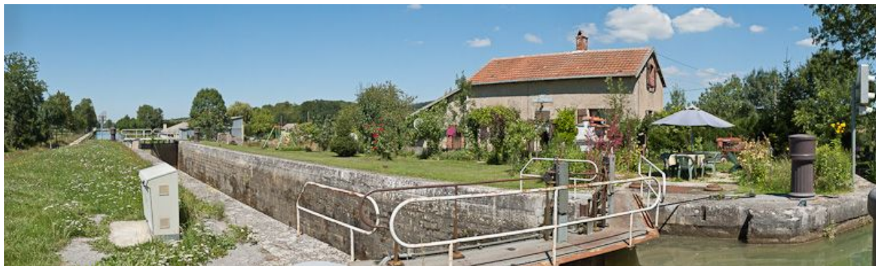
Vue d'ensemble du site d'écluse.
