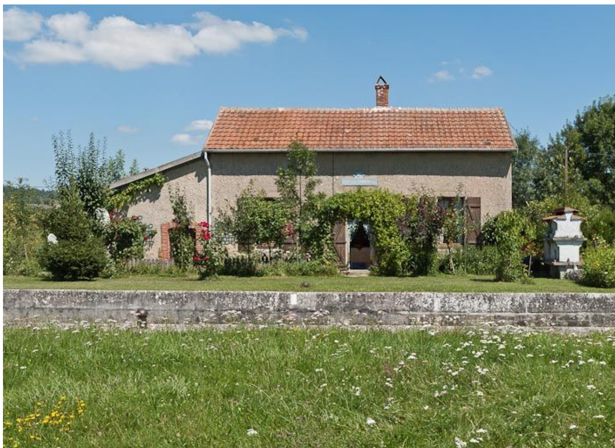
Vue de face de la maison éclusière.
