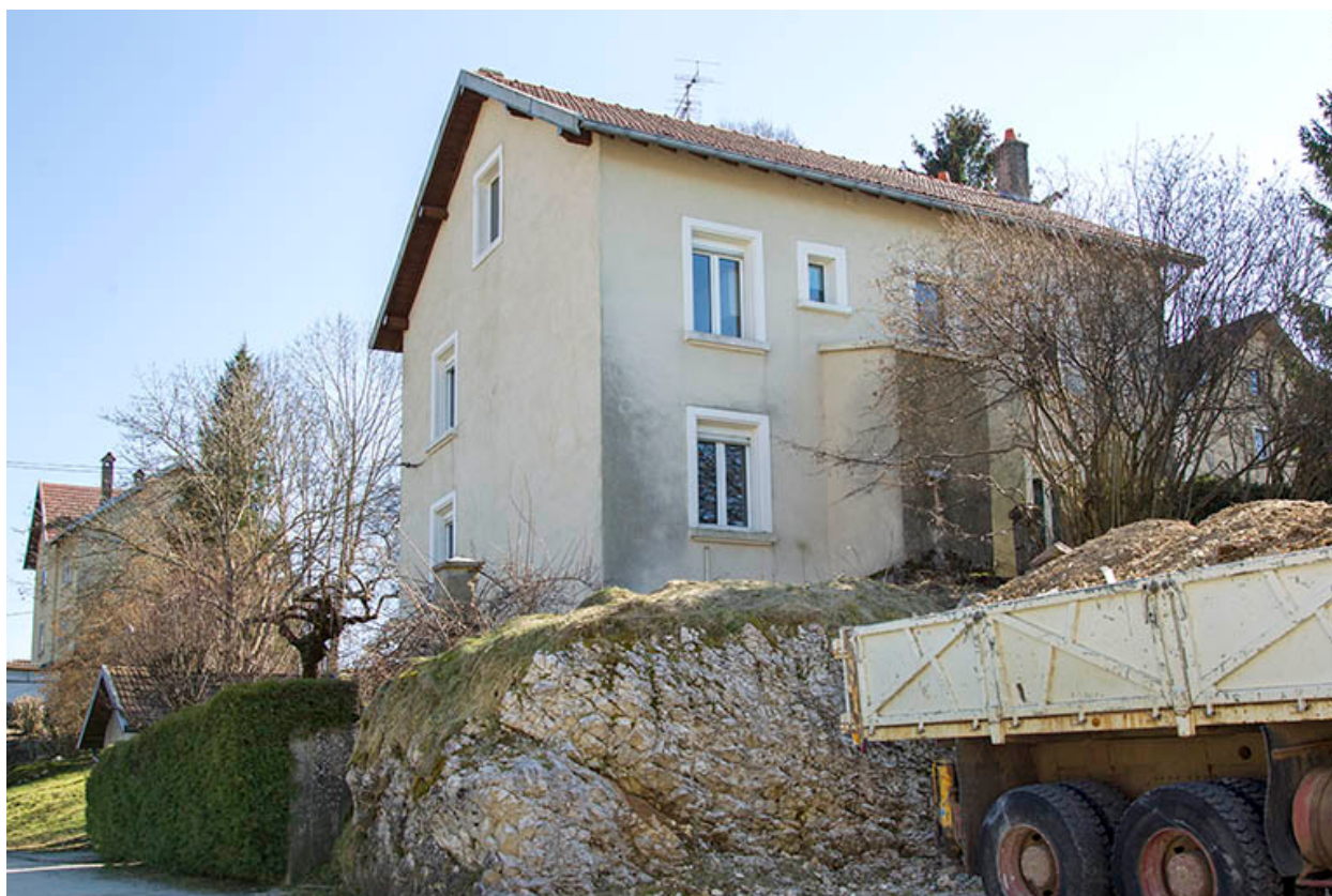
Façades postérieure et latérale droite.
