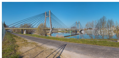
Le pont de Bourgogne, vu d'amont. Phot. Thierry Kuntz IVR26_20217100040NUC4A
