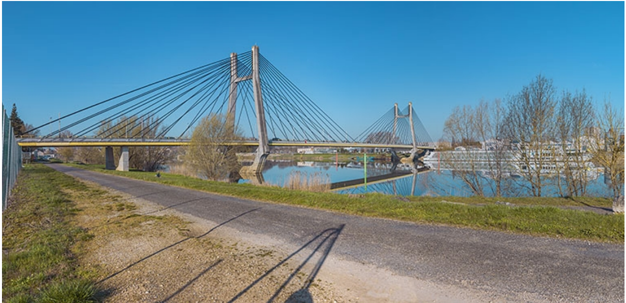
Le pont de Bourgogne, vu d'amont.
