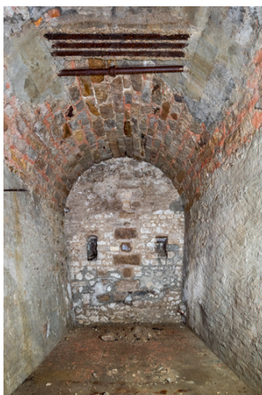
Ancienne halle au blé : cave voûtée sous la terrasse. Phot. Pierre-Marie Barbe-Richaud IVR26_20238900018NUC4A
