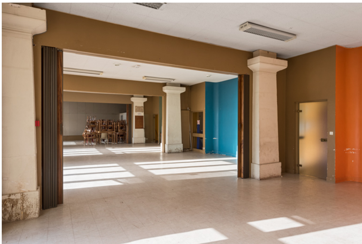
Ancienne halle au blé : alignement de piliers.
