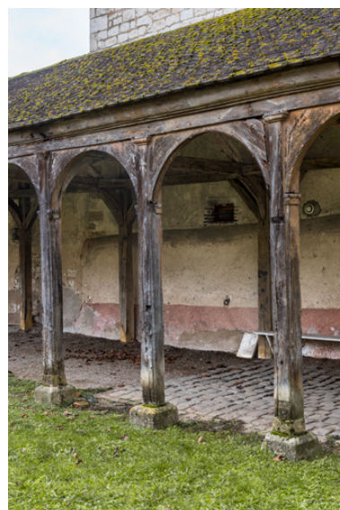
Ancienne halle : deux travées. Phot. Pierre-Marie Barbe-Richaud IVR26_20238900008NUC4A
