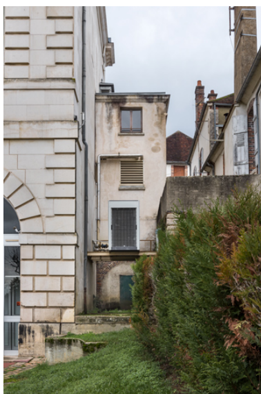
Chaufferie et loge d'acteur contre l'élévation latérale gauche. Phot. Pierre-Marie Barbe-Richaud IVR26_20238900003NUC4A
