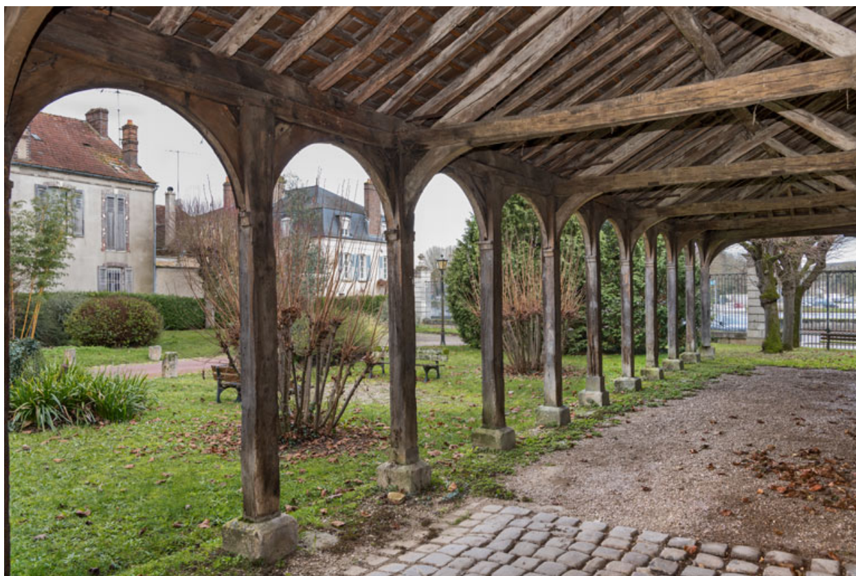
Ancienne halle : vue intérieure avec charpente.
