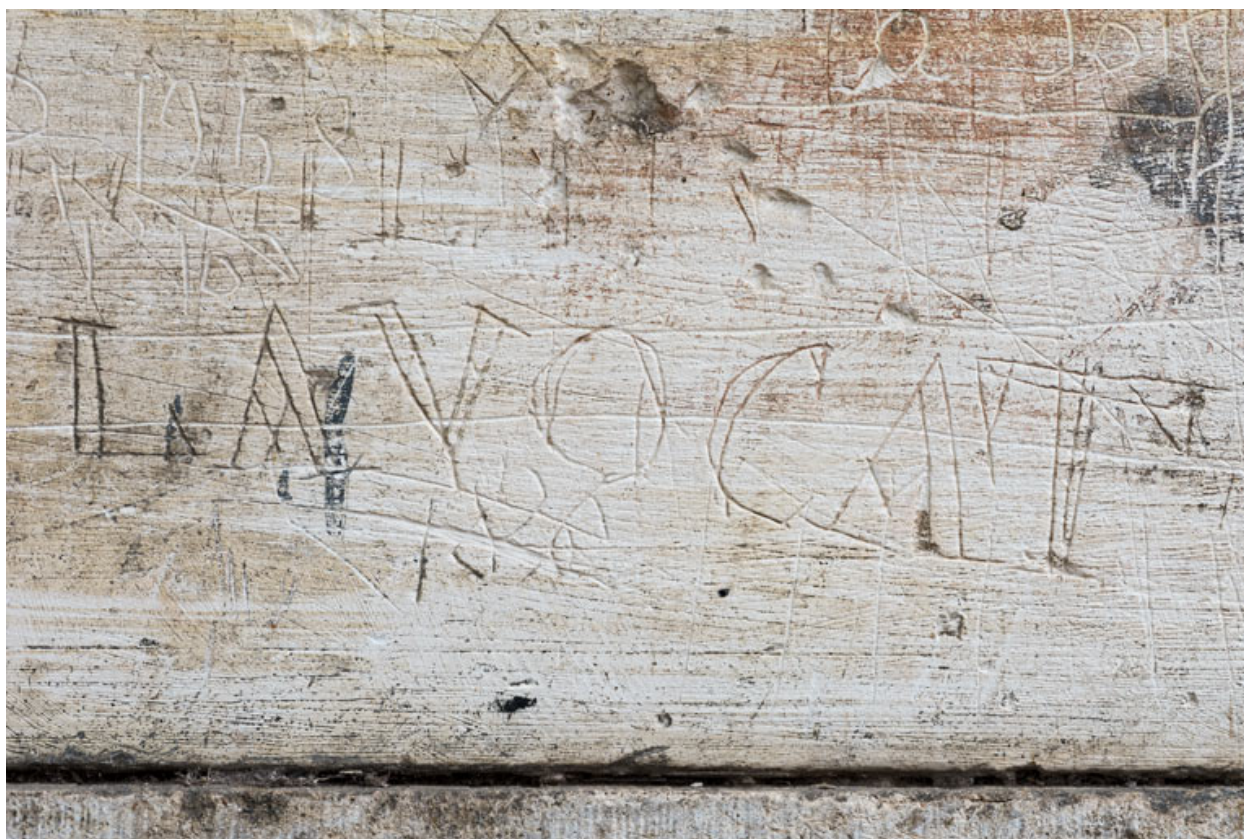
Façade postérieure : graffitis sur un piédroit de porte
