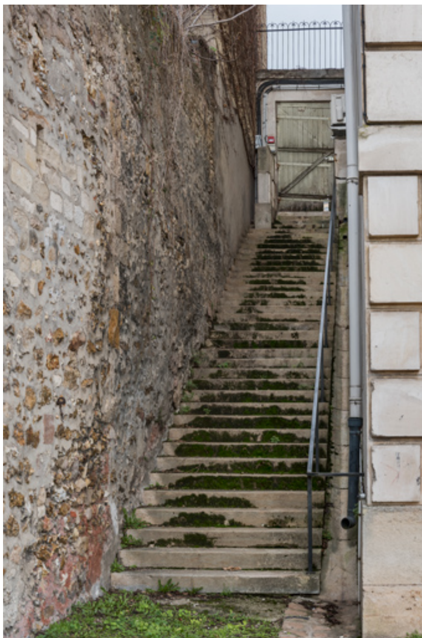
Escalier extérieur contre l'élévation latérale droite.
