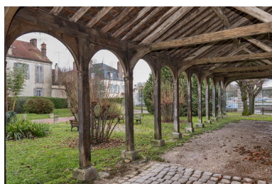
Ancienne halle : vue intérieure avec charpente. Phot. Pierre-Marie Barbe-Richaud IVR26_20238900005NUC4A
