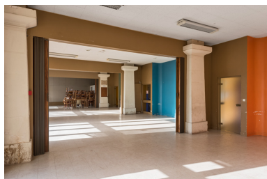
Ancienne halle au blé : alignement de piliers. Phot. Pierre-Marie Barbe-Richaud IVR26_20238900014NUC4A
