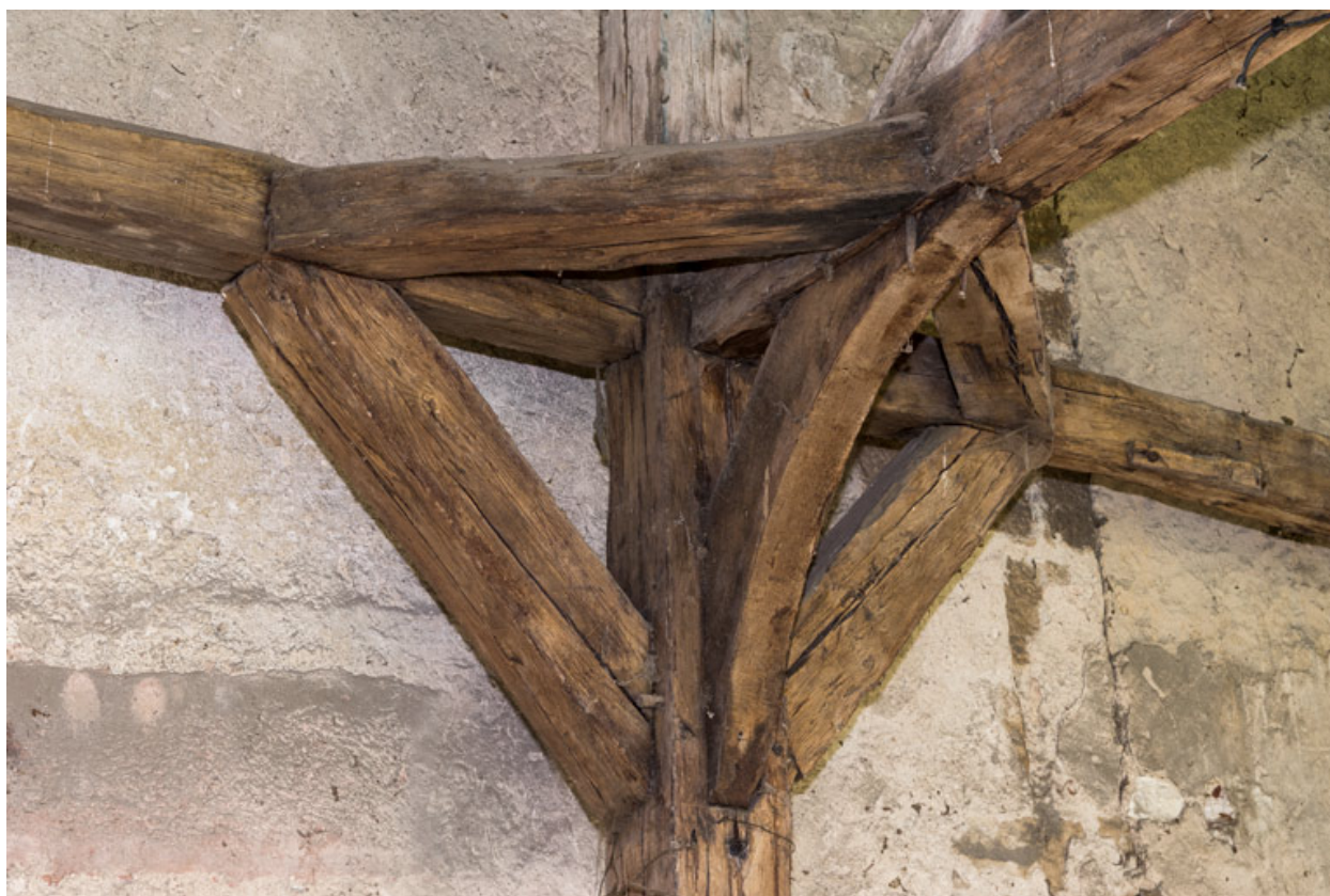
Ancienne halle : détail de la charpente.
