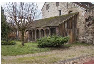
Ancienne halle de 1818-1819, de trois quarts droite. Phot. Pierre-Marie Barbe-Richaud IVR26_20238900004NUC4A
