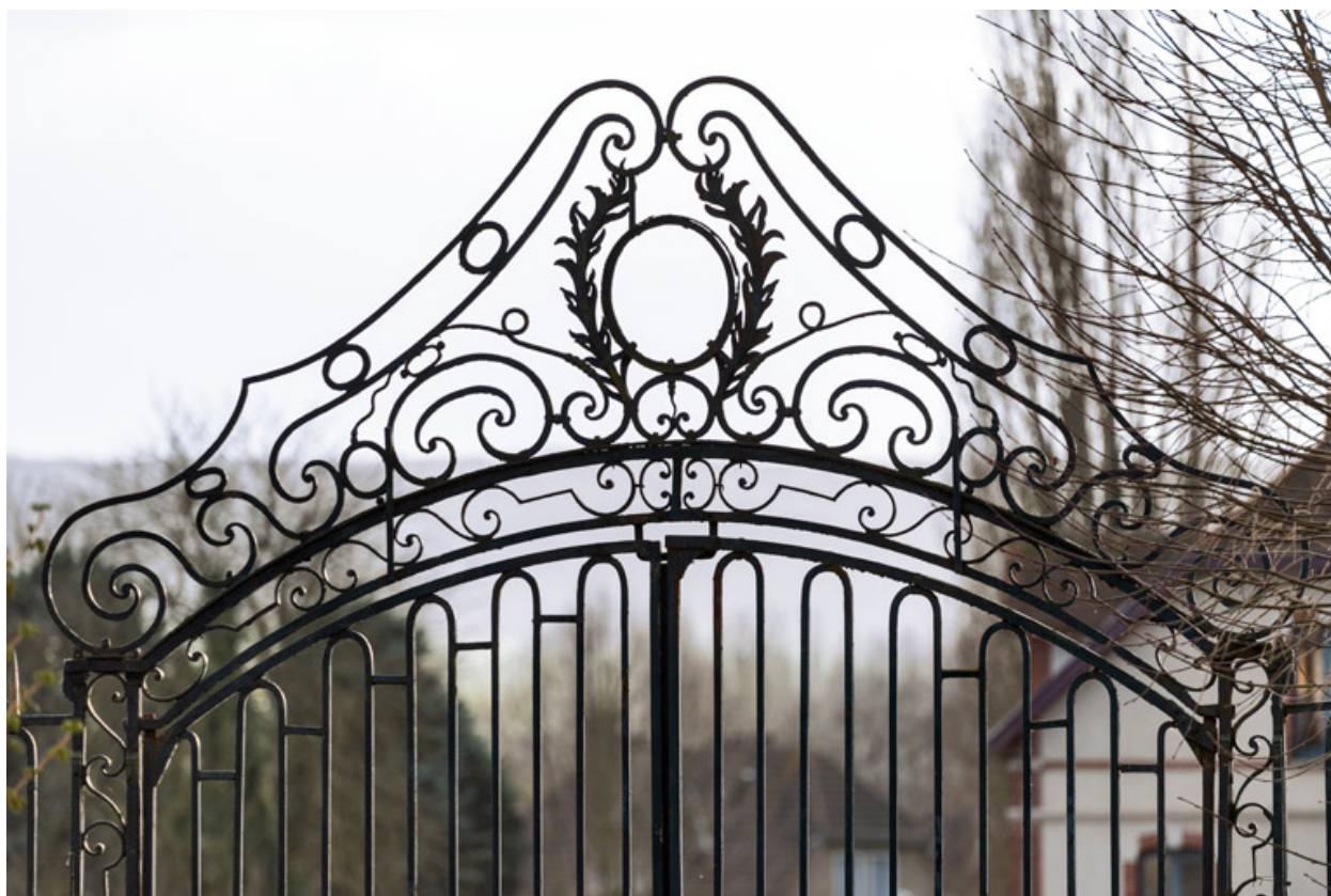
Couronnement de la grille, vu du parc.
