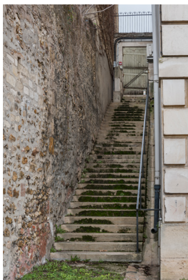
Escalier extérieur contre l'élévation latérale droite. Phot. Pierre-Marie Barbe-Richaud IVR26_20238900009NUC4A
