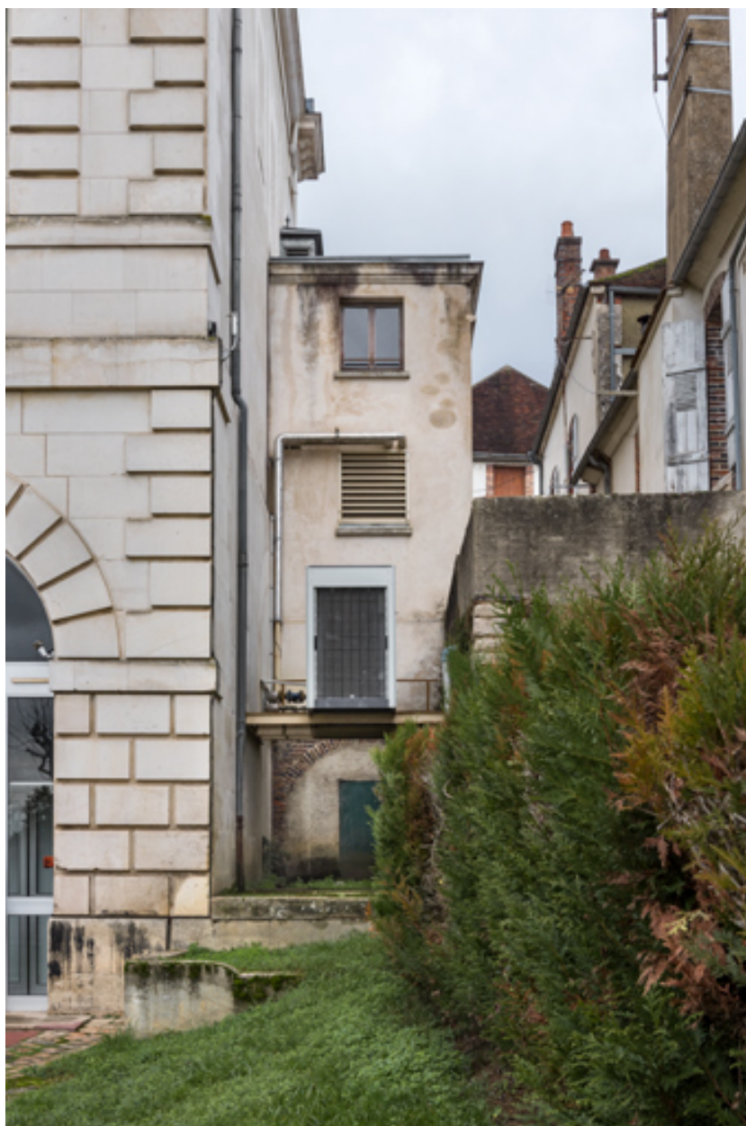
Chaufferie et loge d'acteur contre l'élévation latérale gauche.
