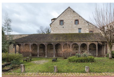
Ancienne halle de 1818-1819. Phot. Pierre-Marie Barbe-Richaud IVR26_20238900021NUC4A
