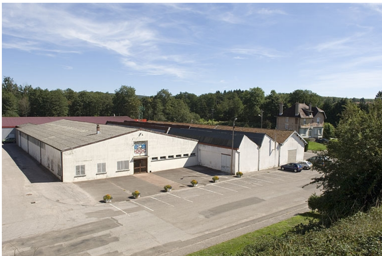
Vue plongeante depuis l'ouest.
