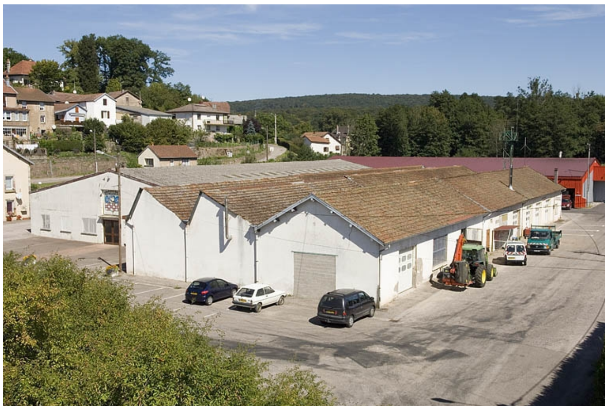
Vue depuis le sud-ouest.
