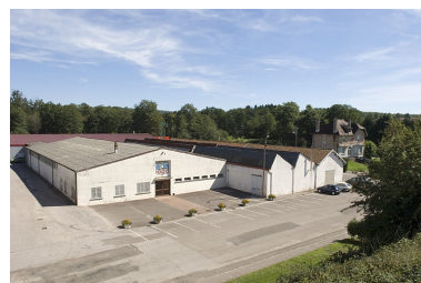
Vue plongeante depuis l'ouest. Phot. Jérôme Mongreville IVR43_20067000773NUCA
