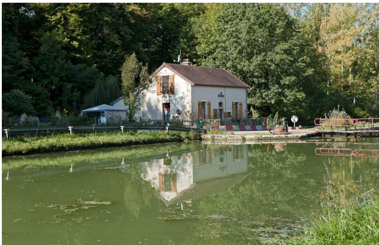
Vue du site d'écluse depuis l'amont.
