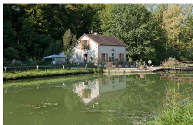
Vue du site d'écluse depuis l'amont. Phot. Pierre-Marie Barbe-Richaud IVR26_20112104138NUC4AQ
