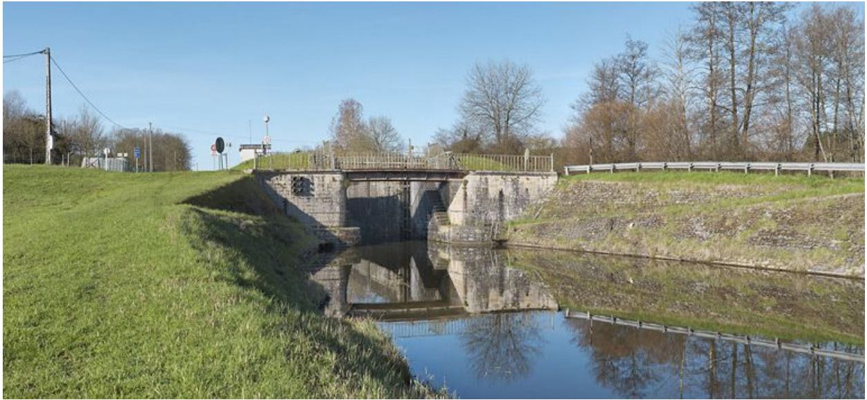
Vue d'ensemble, prise d'aval.
