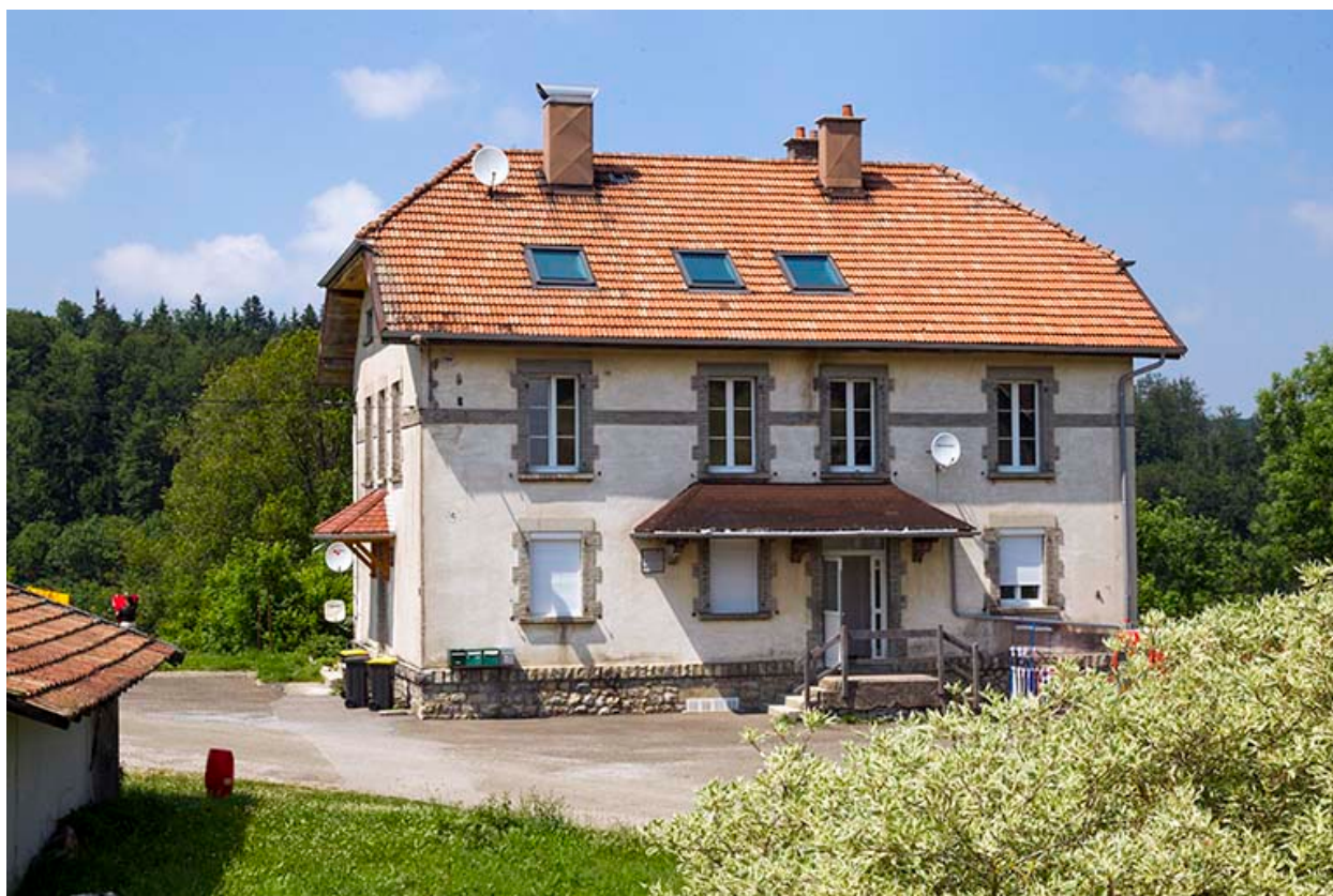
Façade latérale droite, de trois quarts gauche.
