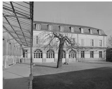
Façade latérale gauche. Phot. Yves Sancey IVR43_19833900676X
