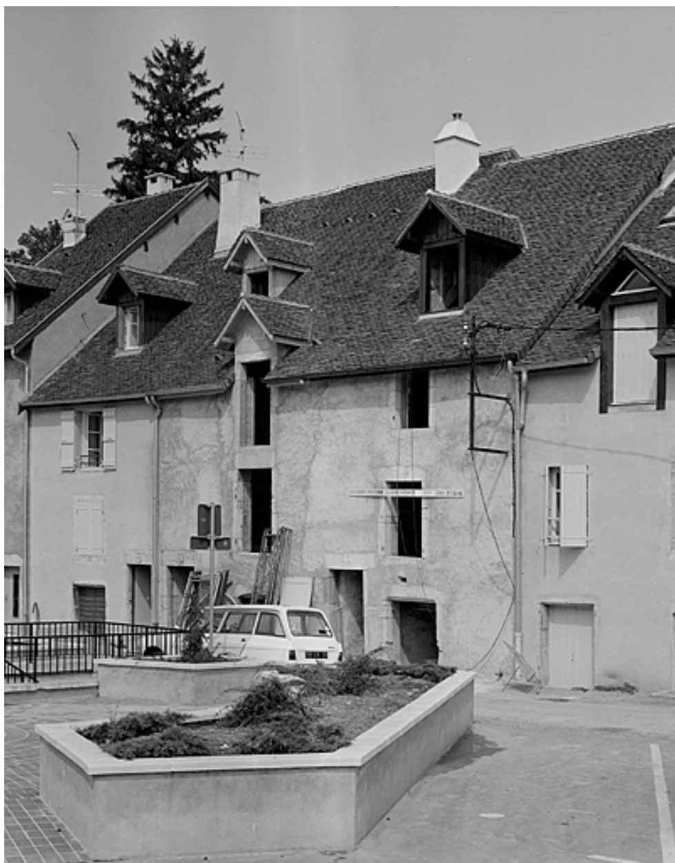
Façade antérieure avant réfection de l'enduit.
