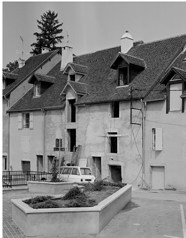
Façade antérieure avant réfection de l'enduit. Phot. Yves Sancey IVR43_19833900364X
