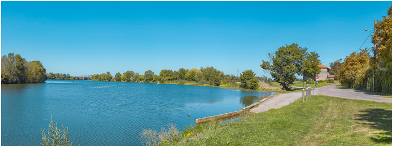
Vue d'ensemble de la cale double.
