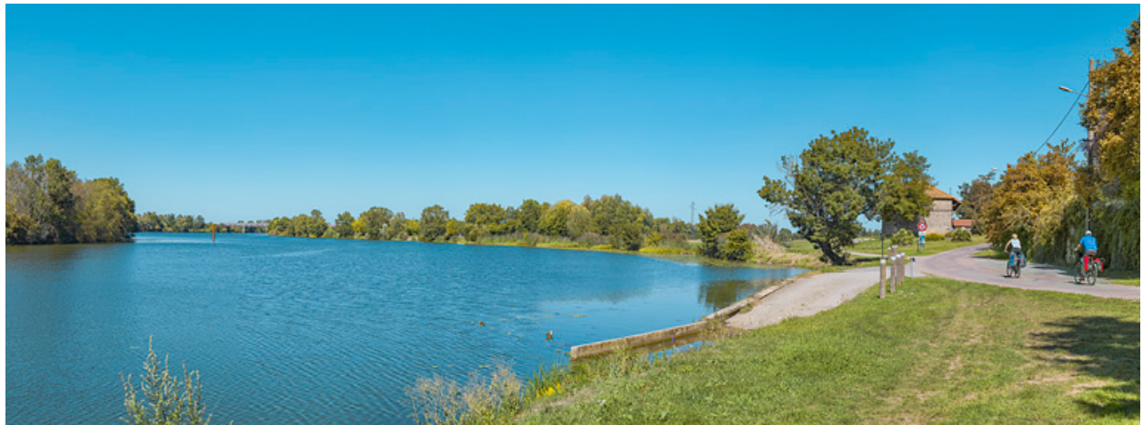
Vue d'ensemble de la cale double.
