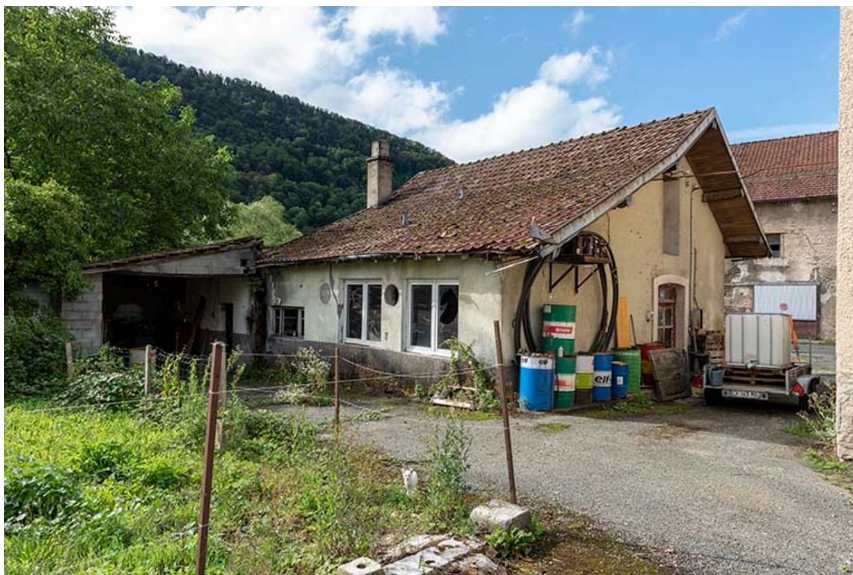
Façades antérieure et latérale gauche.
