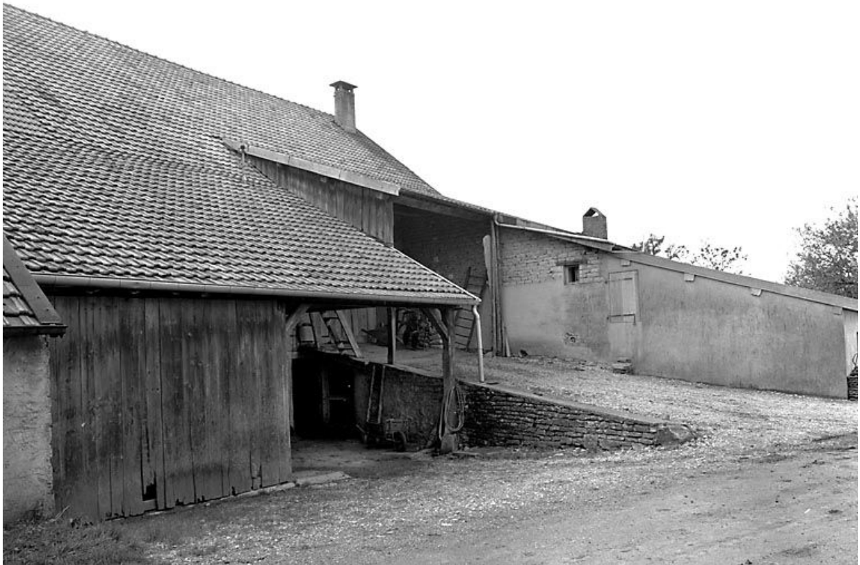
Façade latérale gauche : le pont de grange.
