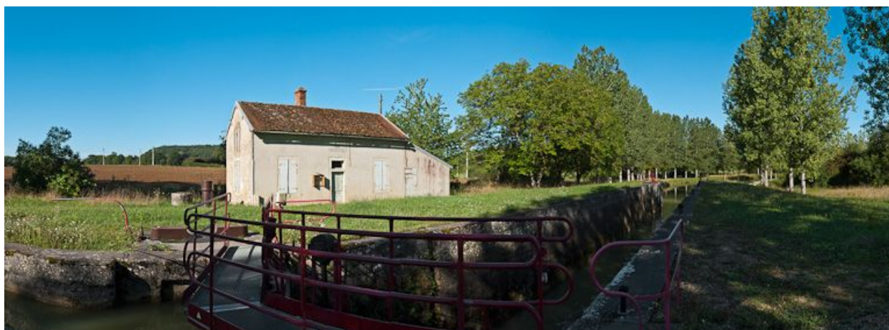
Vue d'ensemble du site d'écluse.
