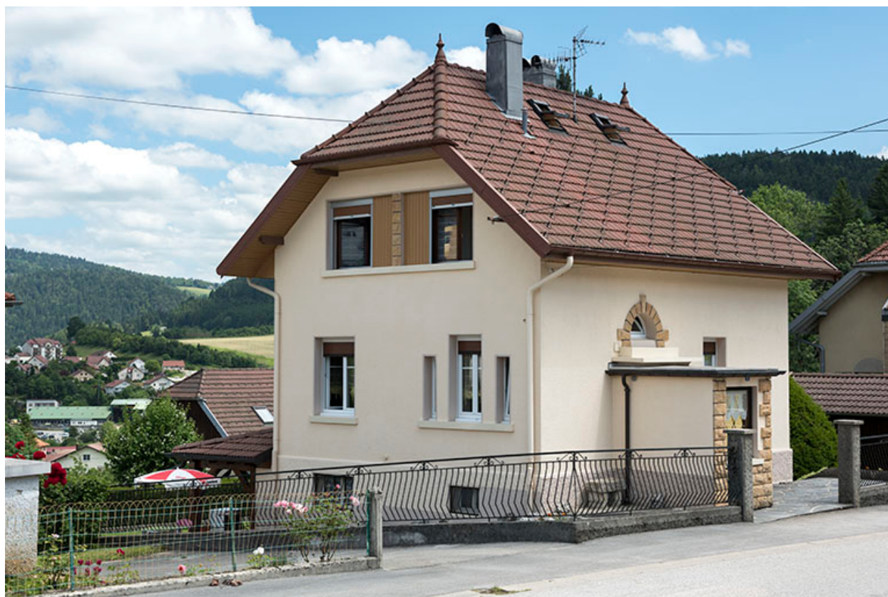
Façades antérieure et latérale gauche.
