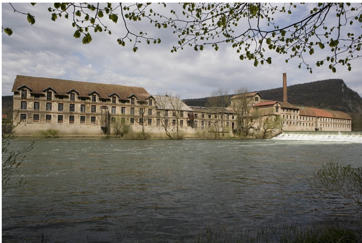
Usine de papeterie Outhenin-Chalandre à Deluz.
