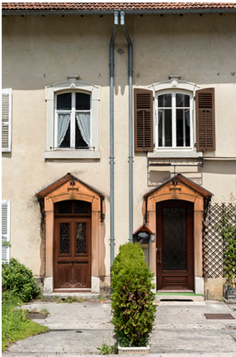
Maison, façade antérieure : travées centrales.
