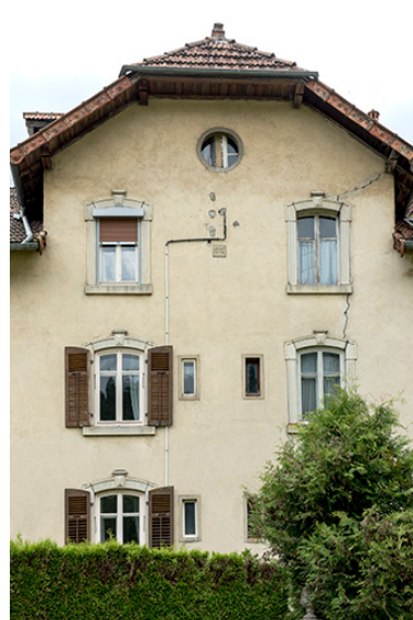
Maison, façade postérieure : travées centrales. Phot. Sonia Dourlot IVR43_20172500426NUC4A
