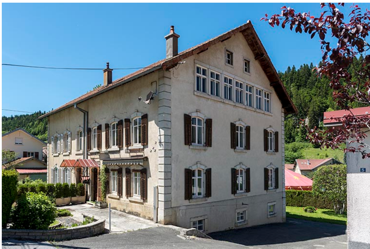
Maison : façades antérieure et latérale droite.
