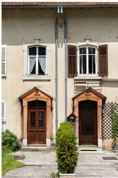
Maison, façade antérieure : travées centrales. Phot. Sonia Dourlot IVR43_20172500425NUC4A
