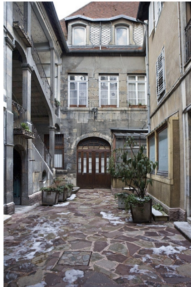
Vue d'ensemble de la cour. Phot. Yves Sancey IVR43_20102500277NUC2A
