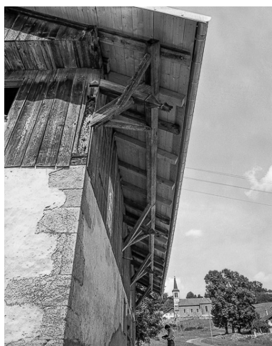
Ferme située au lieu-dit Le Pissoux : extrémité des arbalétriers. Phot. Dominique Humbert IVR43_19762500433X
