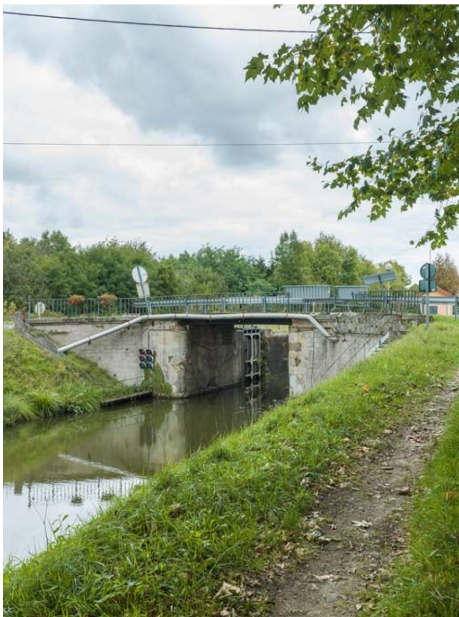
Vue d'ensemble du pont.
