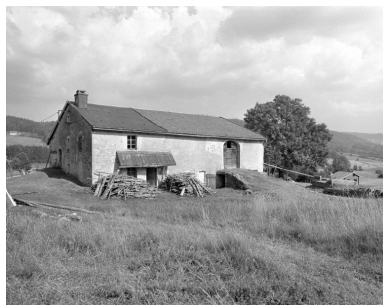
Ferme située au lieu-dit en Désertin sud. Phot. Jérôme Mongreville IVR43_19943900802X
