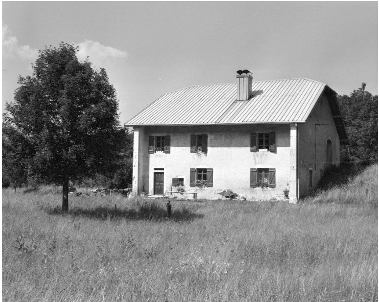
Ferme située au lieu-dit en Désertin
