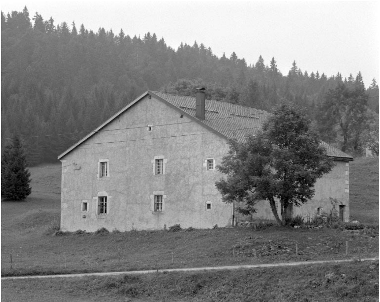
Ferme située au lieu-dit sur la Roche.
