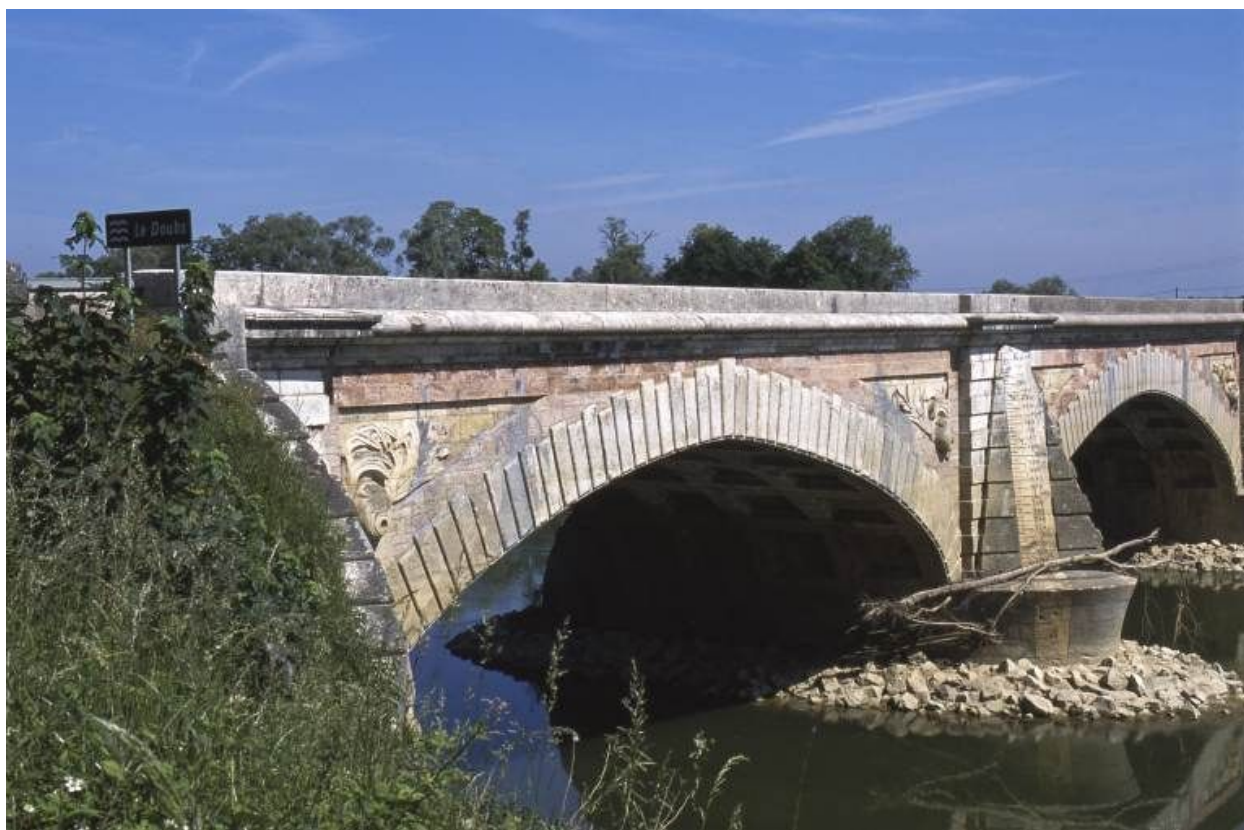
Détail d'une arche.
