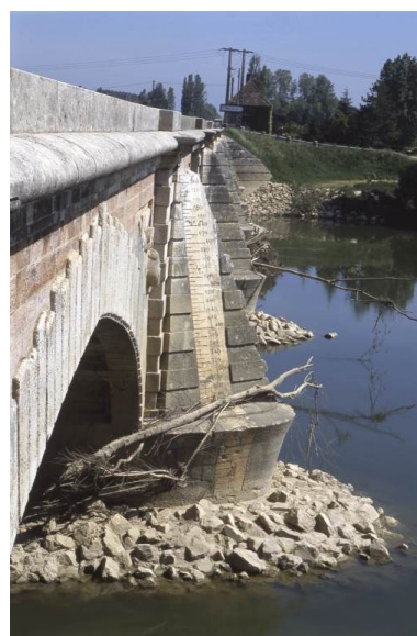
Détail d'une pile. Phot. Jean-Luc Duthu IVR26_20017100194ZA
