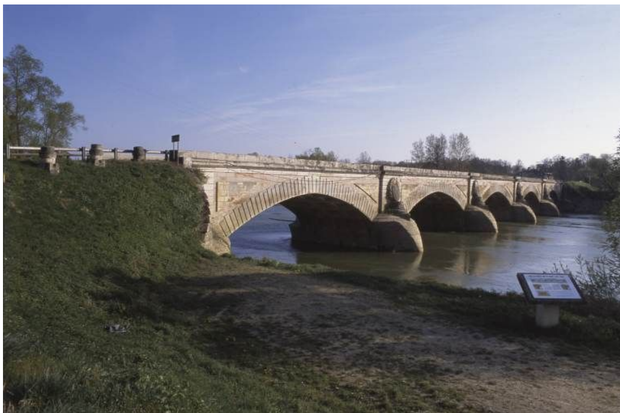
Vue d'ensemble de trois-quarts gauche, en aval.
