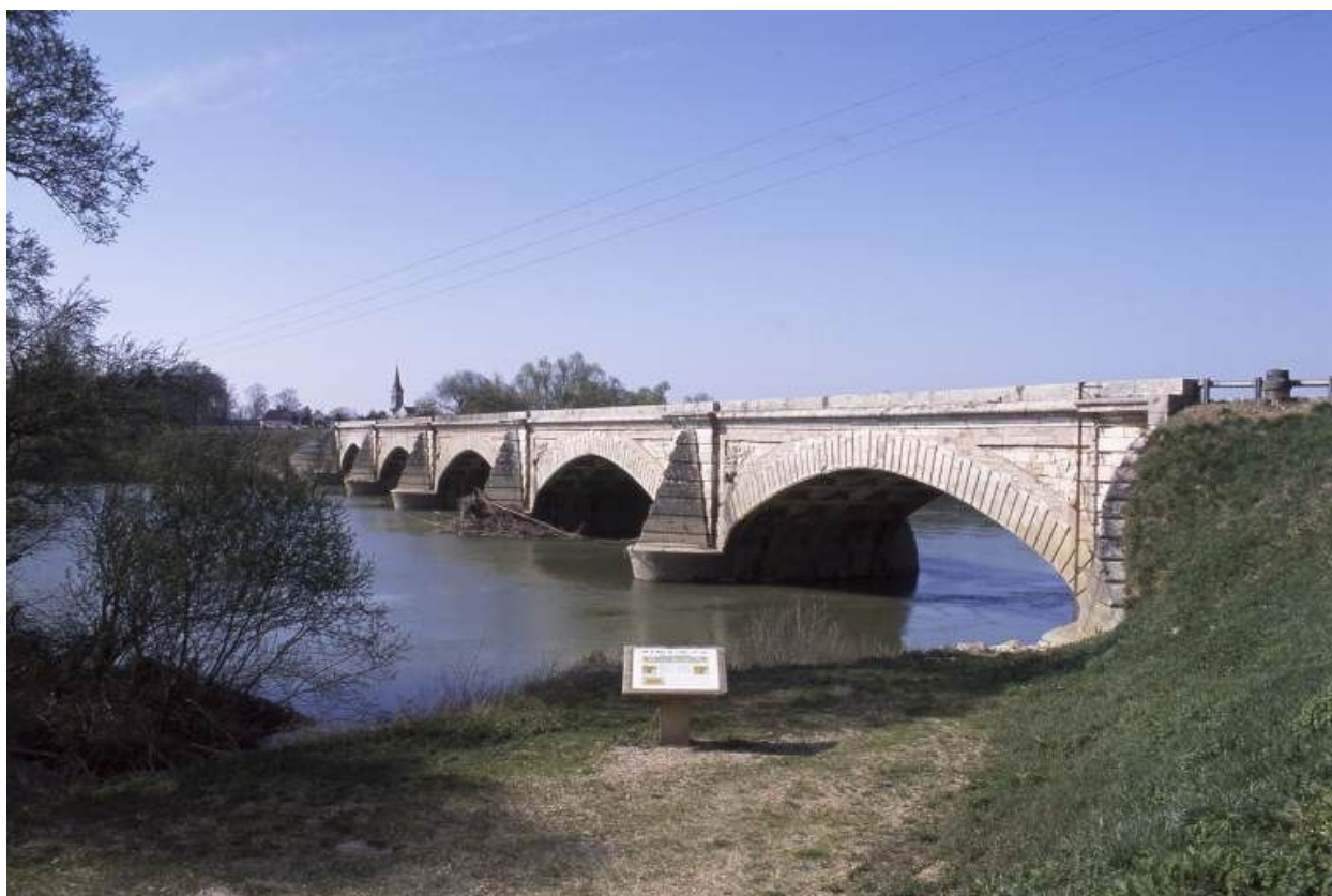
Vue d'ensemble en amont.
