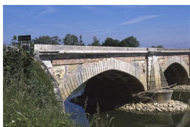
Détail d'une arche. Phot. Jean-Luc Duthu IVR26_20017100195ZA
