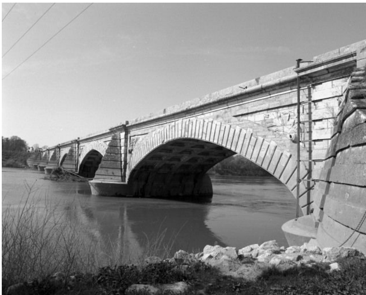
Vue d'ensemble rapprochée, en amont.
