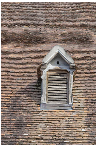
Détail d'une lucarne. Phot. Thierry Kuntz IVR26_20232100509NUC4A
