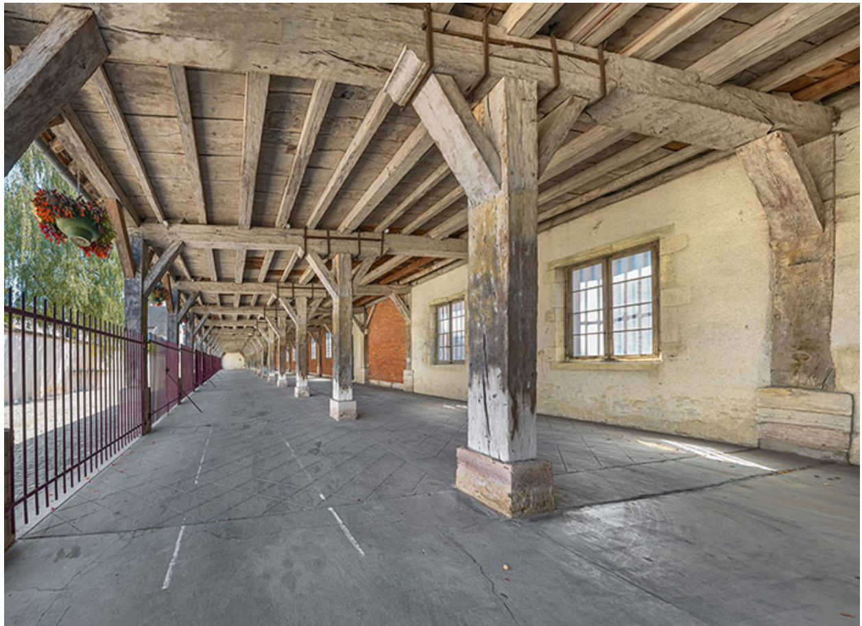
La charpente du hangar.
