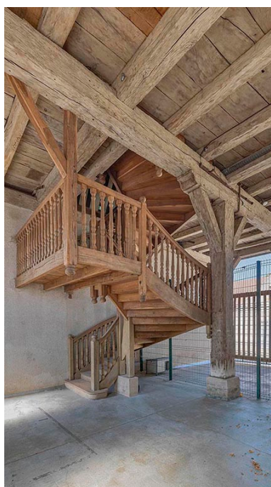
Escalier desservant l'étage supérieur du hangar. Phot. Thierry Kuntz IVR26_20232100399NUC4A
