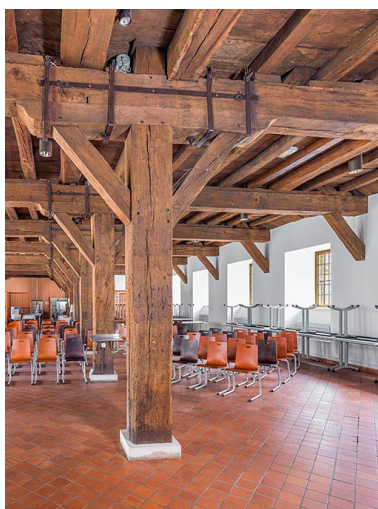
Détail d'un pilier. Phot. Thierry Kuntz IVR26_20232100403NUC4A
