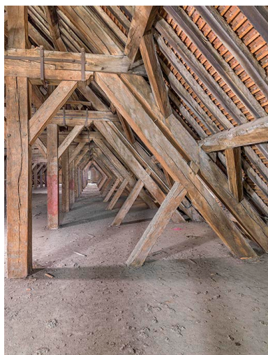
Détail de la charpente à chevrons-portant-fermes. Phot. Thierry Kuntz IVR26_20232100397NUC4A
