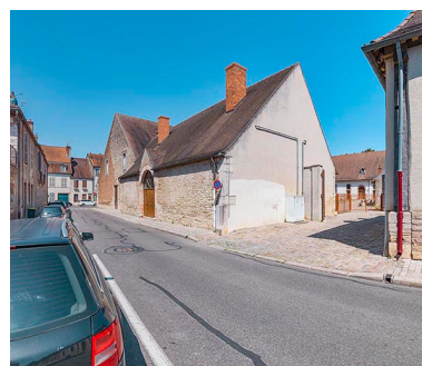
L'atelier des menuisiers. Phot. Thierry Kuntz IVR26_20232100510NUC4A
