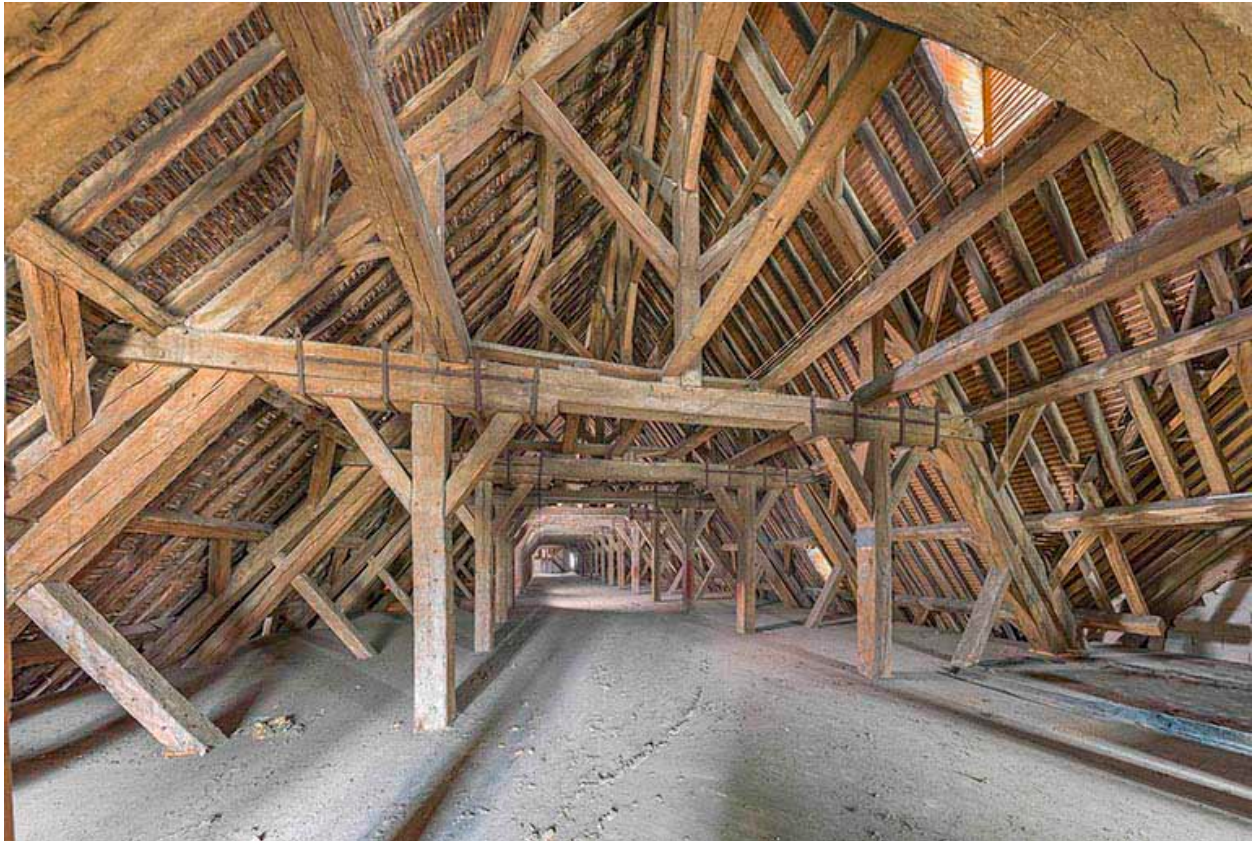
Charpente des grandes halles.
