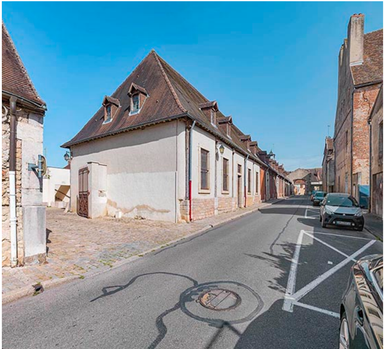
Le hangar depuis la rue des Halles.
