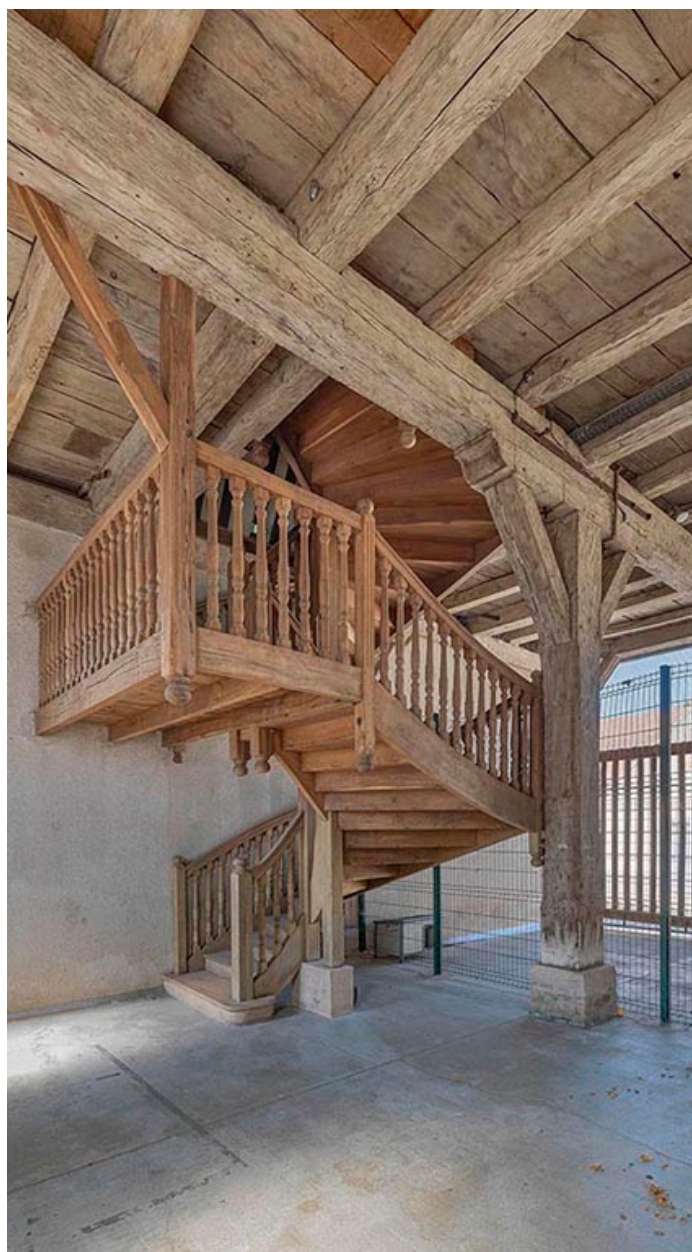
Escalier desservant l'étage supérieur du hangar.
