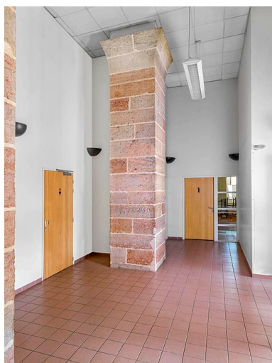
Détail d'un des piliers. Phot. Thierry Kuntz IVR26_20232100405NUC4A
