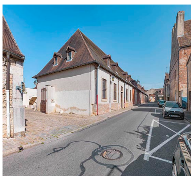
Le hangar depuis la rue des Halles. Phot. Thierry Kuntz IVR26_20232100400NUC4A
