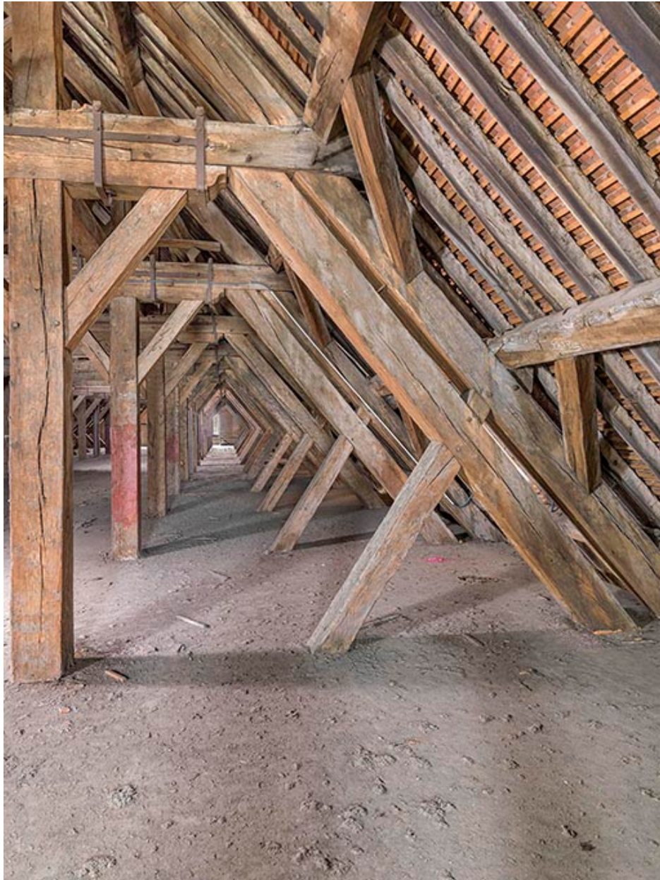
Détail de la charpente à chevrons-portant-fermes.
