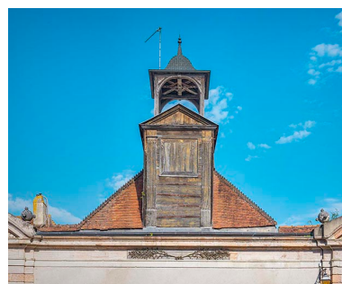
Le lanternon. Phot. Thierry Kuntz IVR26_20232100504NUC4A
