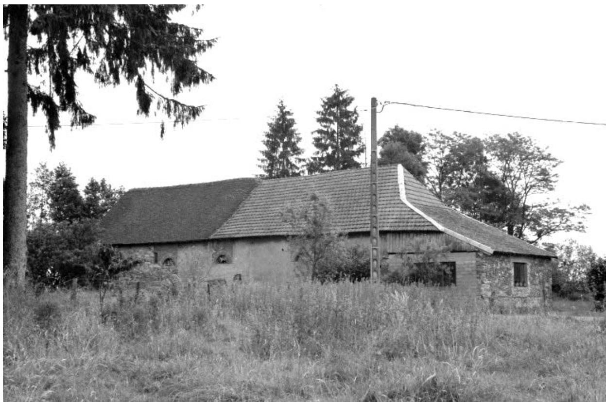
Atelier de fabrication (B), depuis le sud-ouest.
