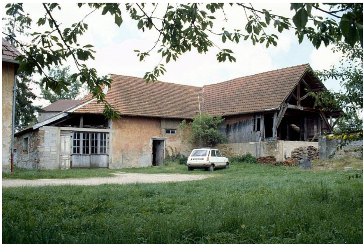
Atelier de fabrication (B), depuis le sud-est.
