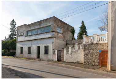
Les bureaux. Phot. Jérôme Mongreville IVR43_20152501015NUC4A
