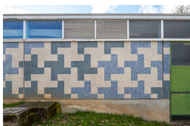
Détail de la façade nord-est. Phot. Aline Thomas IVR43_20267000060NUC4A
