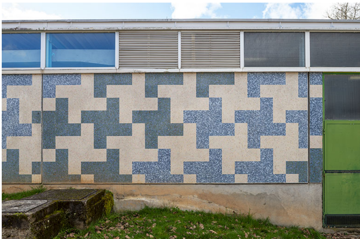
Détail de la façade nord-est.
