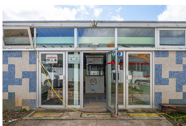
L'entrée de la piscine sur la façade nord-est. Phot. Aline Thomas IVR43_20267000061NUC4A
