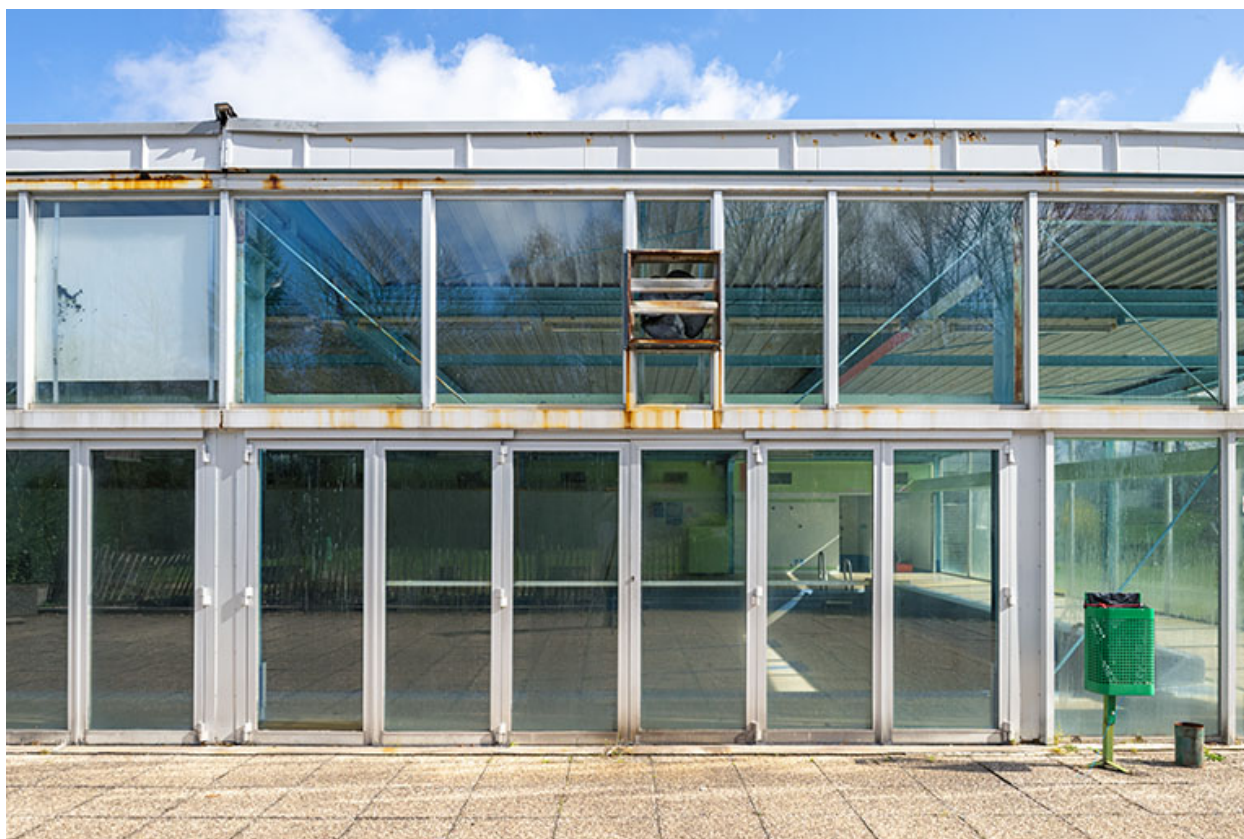
Détail de la façade sud-ouest.
