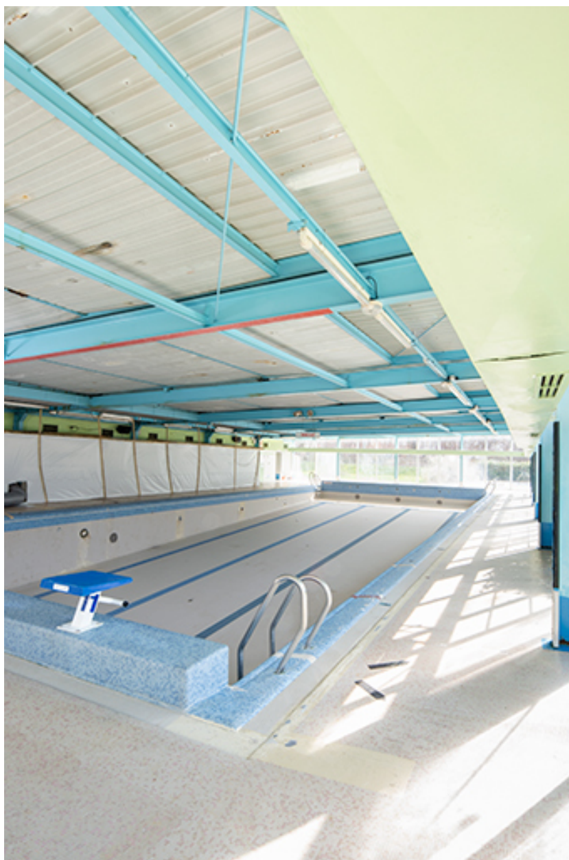
L'ensemble du bassin de la piscine, depuis le nord-ouest.
