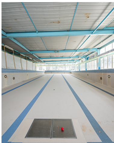
L'ensemble du fond du bassin de la piscine, depuis le nord. Phot. Nicolas Waltefaugle IVR43_20267000015NUC4A
