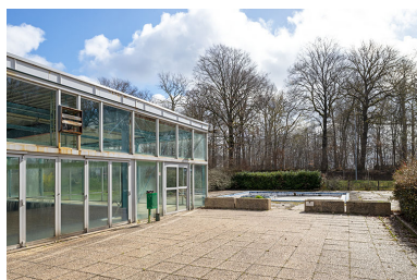
La façade sud-ouest de la piscine et la pataugeoire. Phot. Aline Thomas IVR43_20267000054NUC4A
