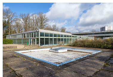
La pataugeoire et la piscine. Phot. Aline Thomas IVR43_20267000051NUC4A
