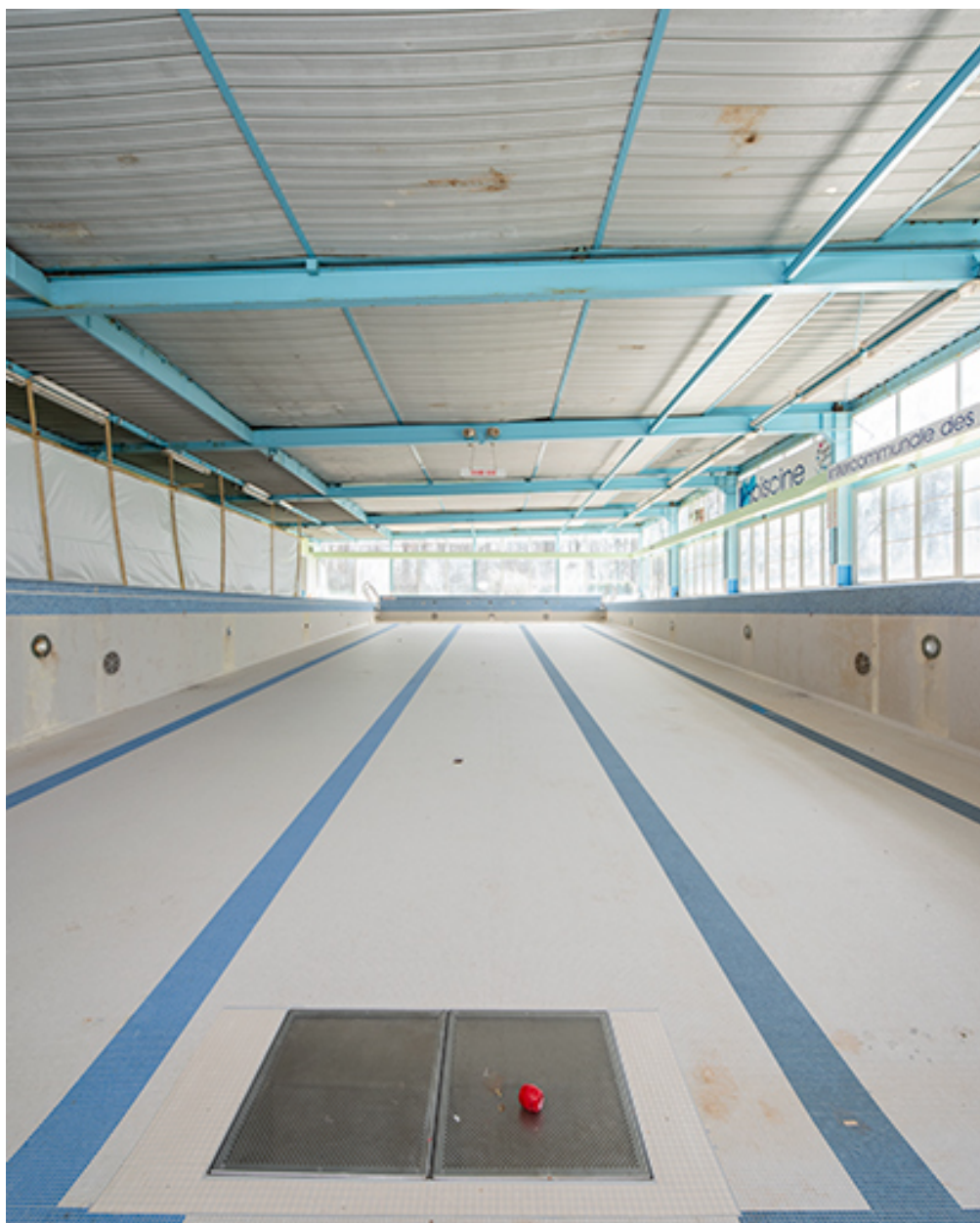
L'ensemble du fond du bassin de la piscine, depuis le nord.
