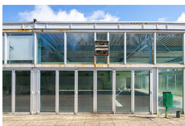
Détail de la façade sud-ouest. Phot. Aline Thomas IVR43_20267000053NUC4A
