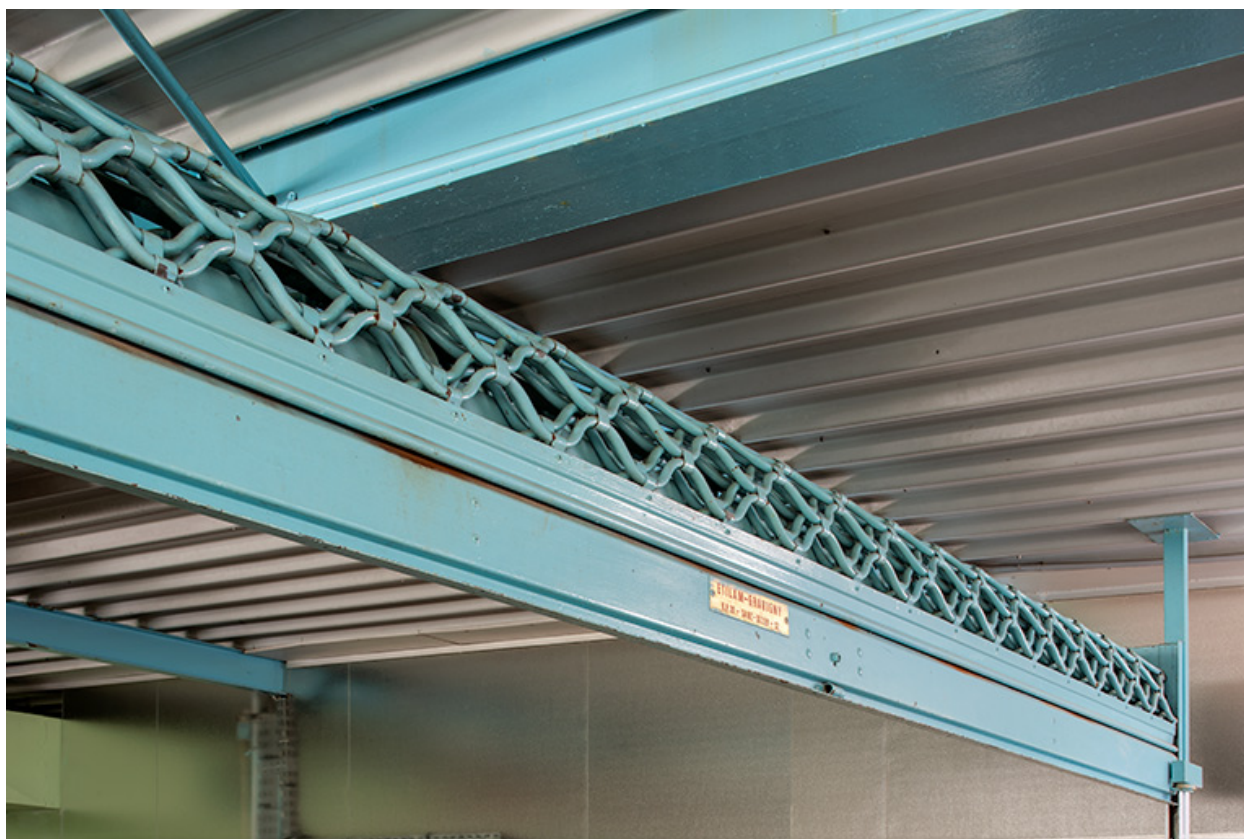
La grille fermant le vestiaire des filles, relevée.
