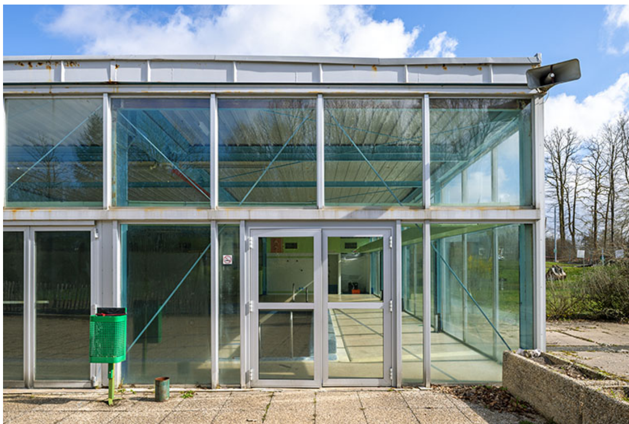
La façade sud-ouest, l'entrée du bassin.
