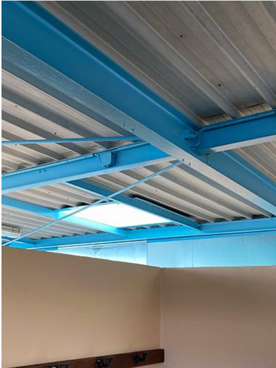
Les poutres métalliques dans les vestiaires.
