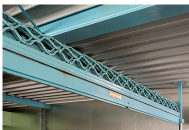
La grille fermant le vestiaire des filles, relevée. Phot. Nicolas Waltefaugle IVR43_20267000007NUC4A
