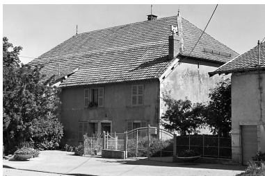
Maison située 1 route de la Barèche.
