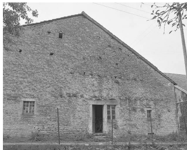
Pignon sur la rue. Phot. Yves Sancey IVR43_19793900162X
