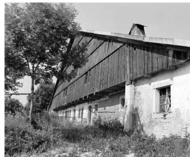
Pignon habitation vu de trois quarts droit. Phot. Yves Sancey IVR43_19782500197X
