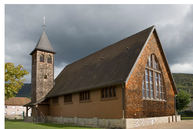
Vue latérale. Phot. Yves Sancey IVR43_20063900093NUCA
