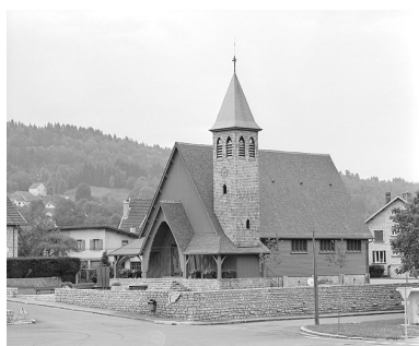
Façade ouest et face sud. Phot. Yves Sancey IVR43_19963900833X
