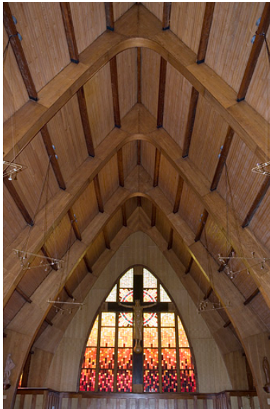
Chœur : Christ en croix. Phot. Yves Sancey IVR43_20063900077NUCA
