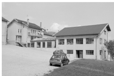
Ancienne tournerie Forestier, vue du sud-est. Phot. Laurent Poupard IVR43_19913901013Z
