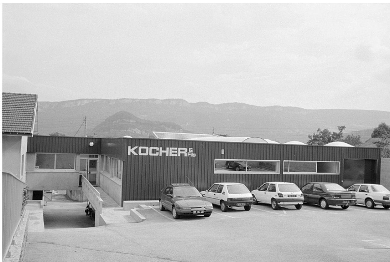
Atelier de fabrication et bureau (D).
