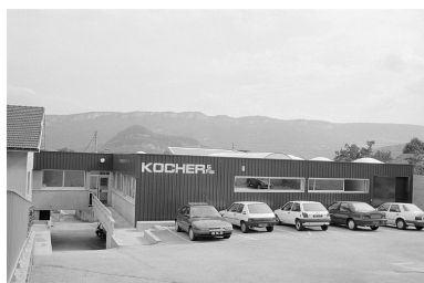
Atelier de fabrication et bureau (D). Phot. Laurent Poupard IVR43_19913901007Z
