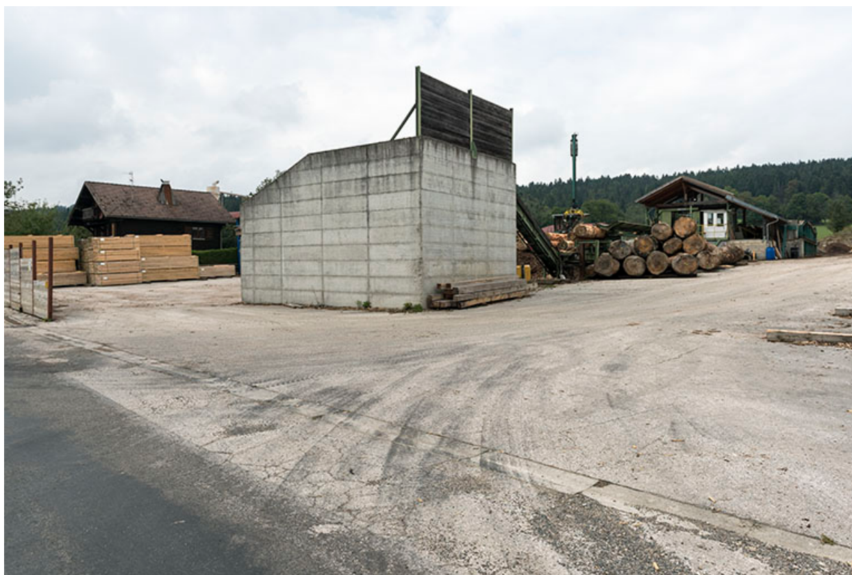
Silo, écorceuse et aire de fabrication.
