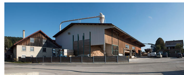
Maison, atelier de fabrication et bureau. Phot. Sonia Dourlot IVR43_20162501330NUC4A
