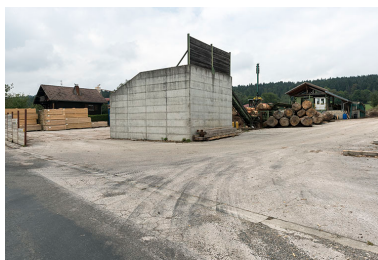
Silo, écorceuse et aire de fabrication. Phot. Sonia Dourlot IVR43_20162501332NUC4A
