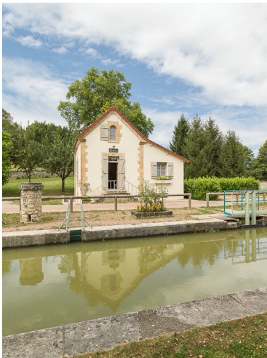
Vue de la maison éclusière.
