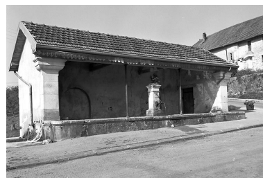
Fontaine de la rue des Moulins. Phot. Yves Sancey IVR43_19802500860X
