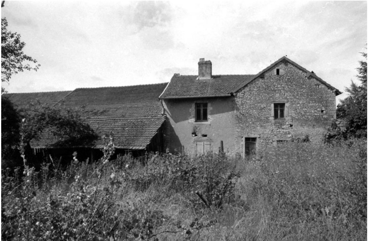
Façade postérieure de la partie gauche.
