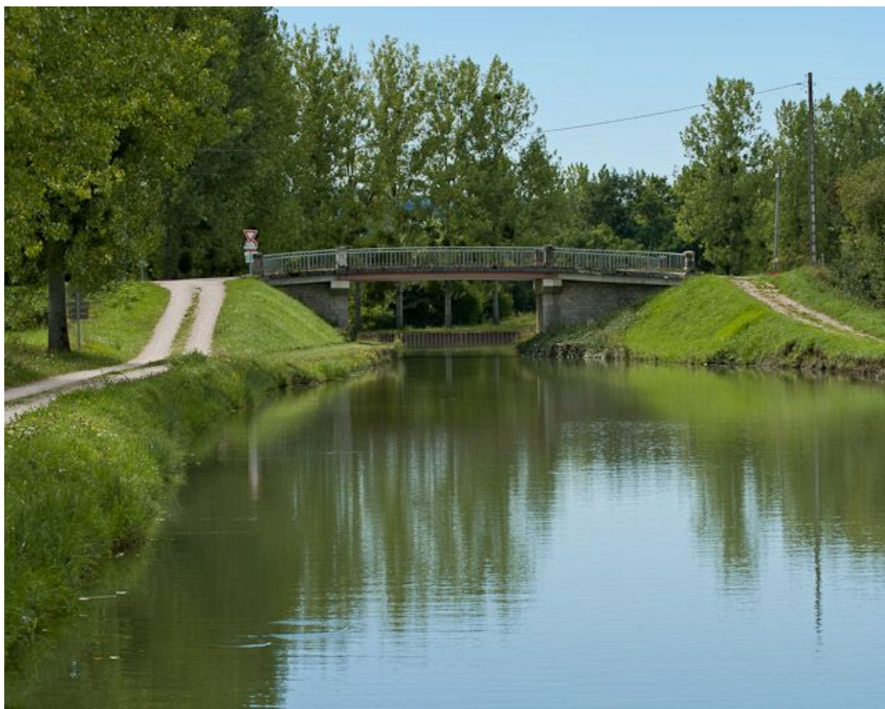
Vue du pont depuis l'amont.
