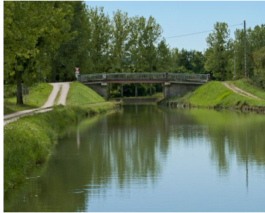
Vue du pont depuis l'amont. Phot. Pierre-Marie Barbe-Richaud IVR26_20112103870NUC4AQ
