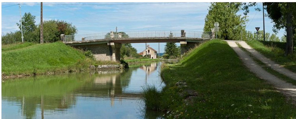
Vue du pont depuis l'aval.
