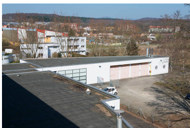
Façade sud des réserves.
