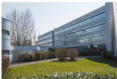
Façade est de l'aile est de l'externat.
