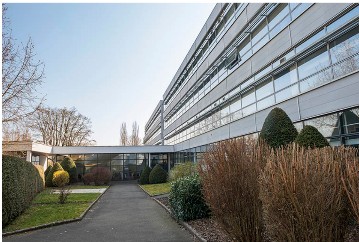
Façade est de l'aile est de l'externat.
