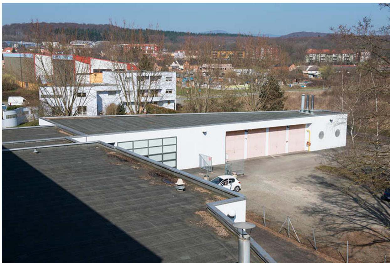
Façade sud des réserves.
