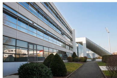
Façade est de l'aile est de l'externat.
