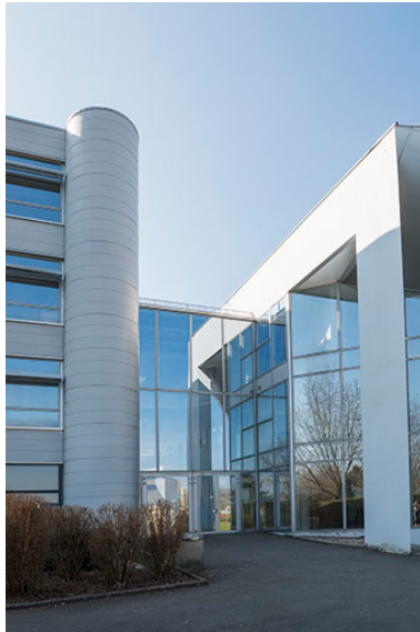
Détail de l'entrée nord-est. Phot. Mary Ruffinoni IVR43_20149000128NUC4A
