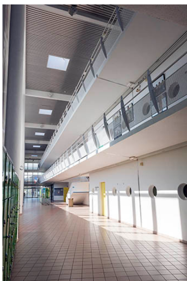
Détails des coursives de la rue intérieure. Phot. Mary Ruffinoni IVR43_20149000120NUC4A
