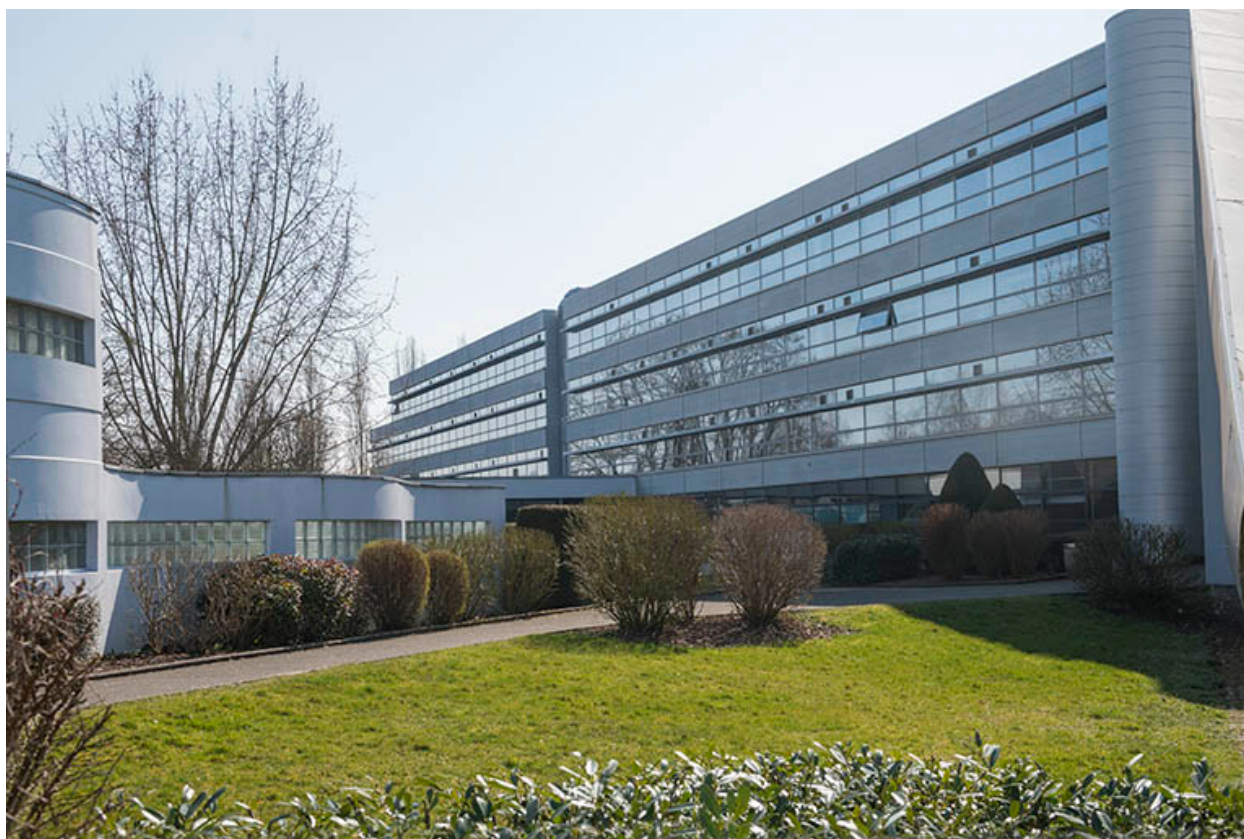
Façade est de l'aile est de l'externat.
