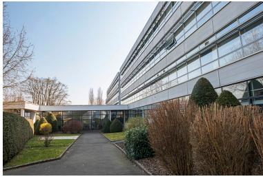
Façade est de l'aile est de l'externat. Phot. Mary Ruffinoni IVR43_20149000143NUC4A
