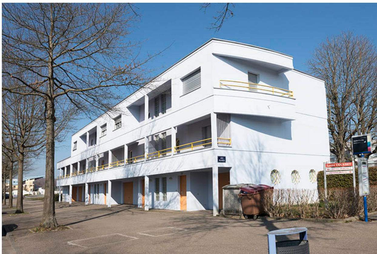
Angle sud-ouest des logements sud-ouest.
