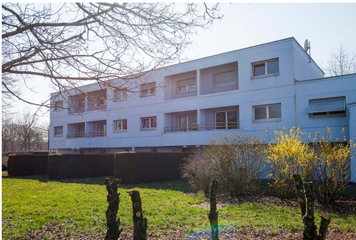
Façade postérieure est des logements sud-ouest.
