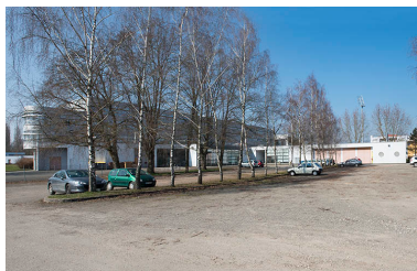
Aire de stationnement à l'est de la parcelle.
