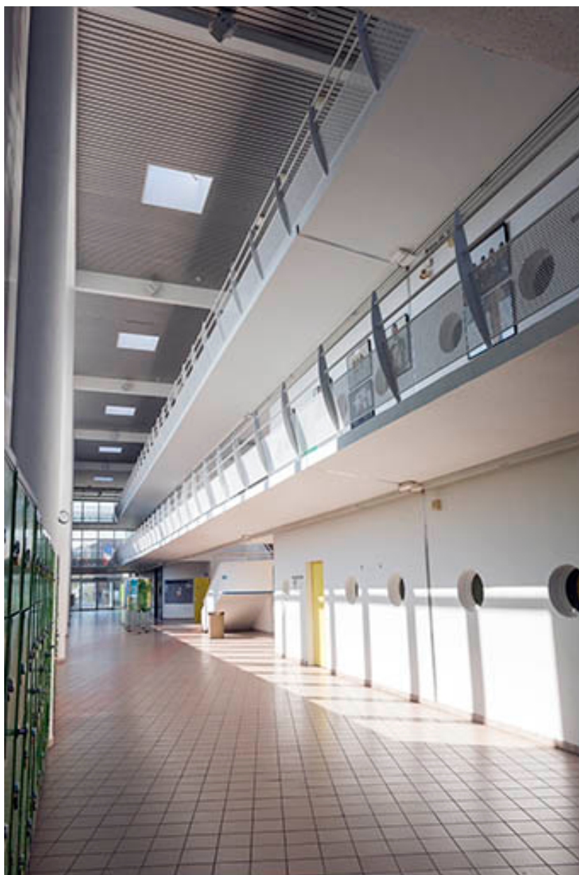
Détails des coursives de la rue intérieure.
