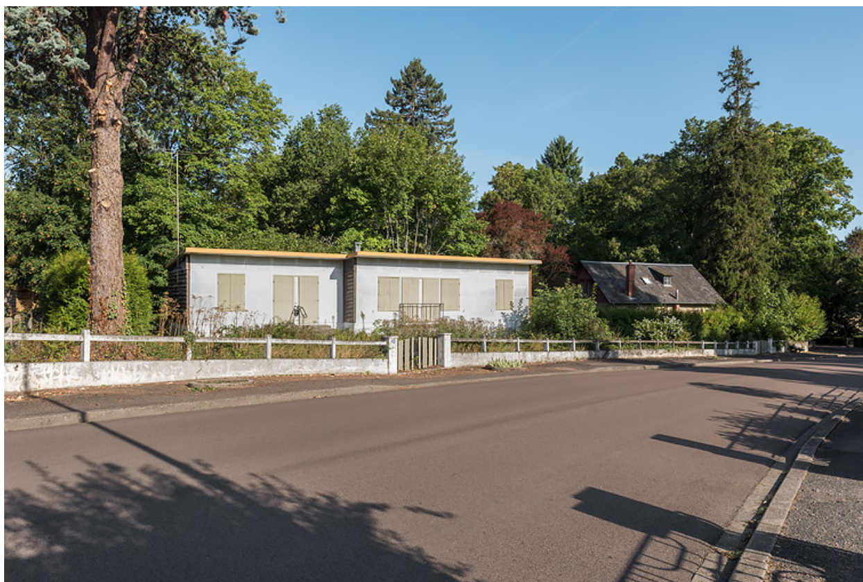
Vue depuis le sud-est.
