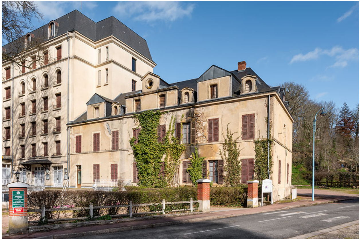
Façade principale, vue depuis le sud-ouest.
