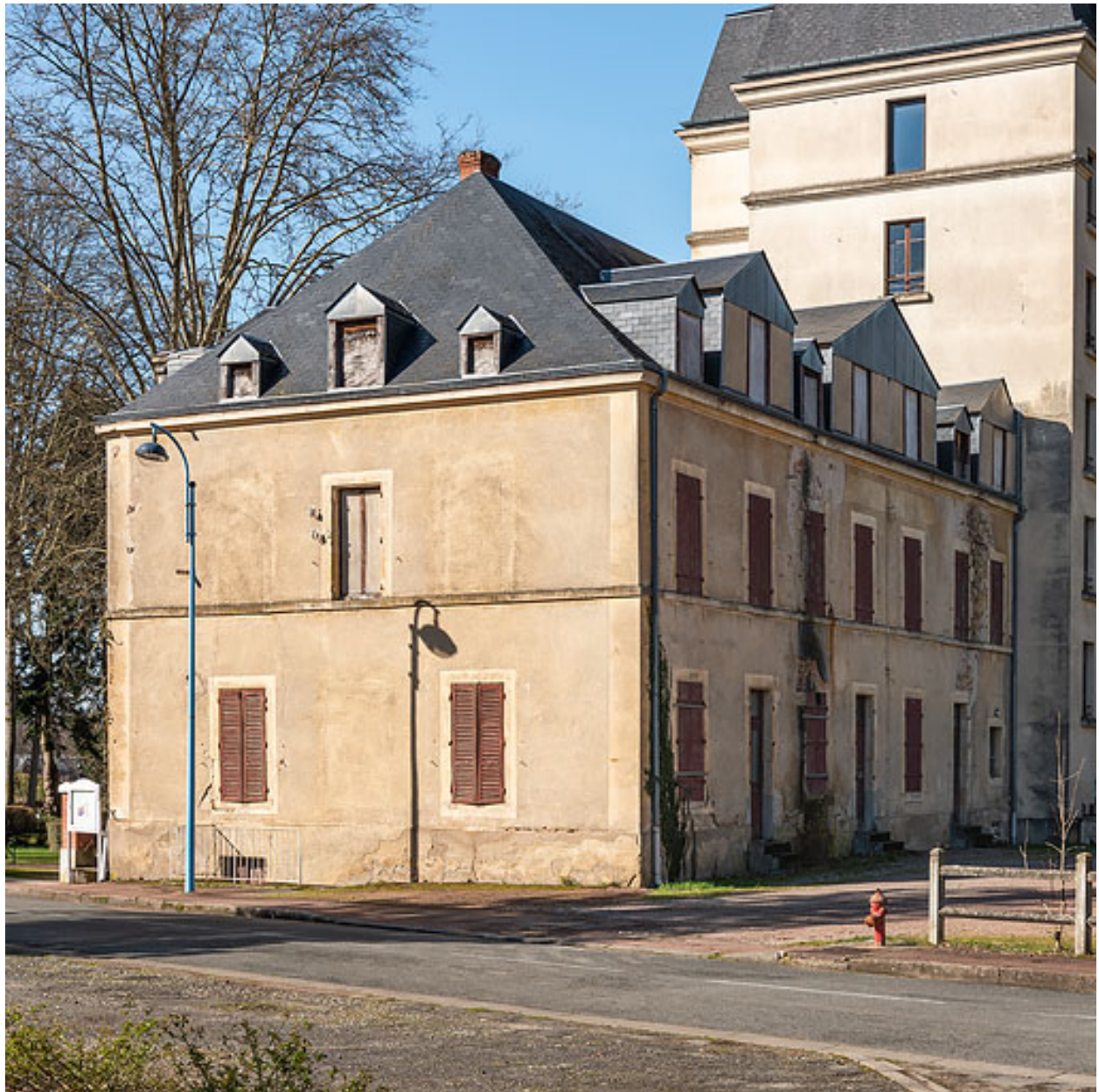
Façade secondaire, vue depuis le sud-est.
