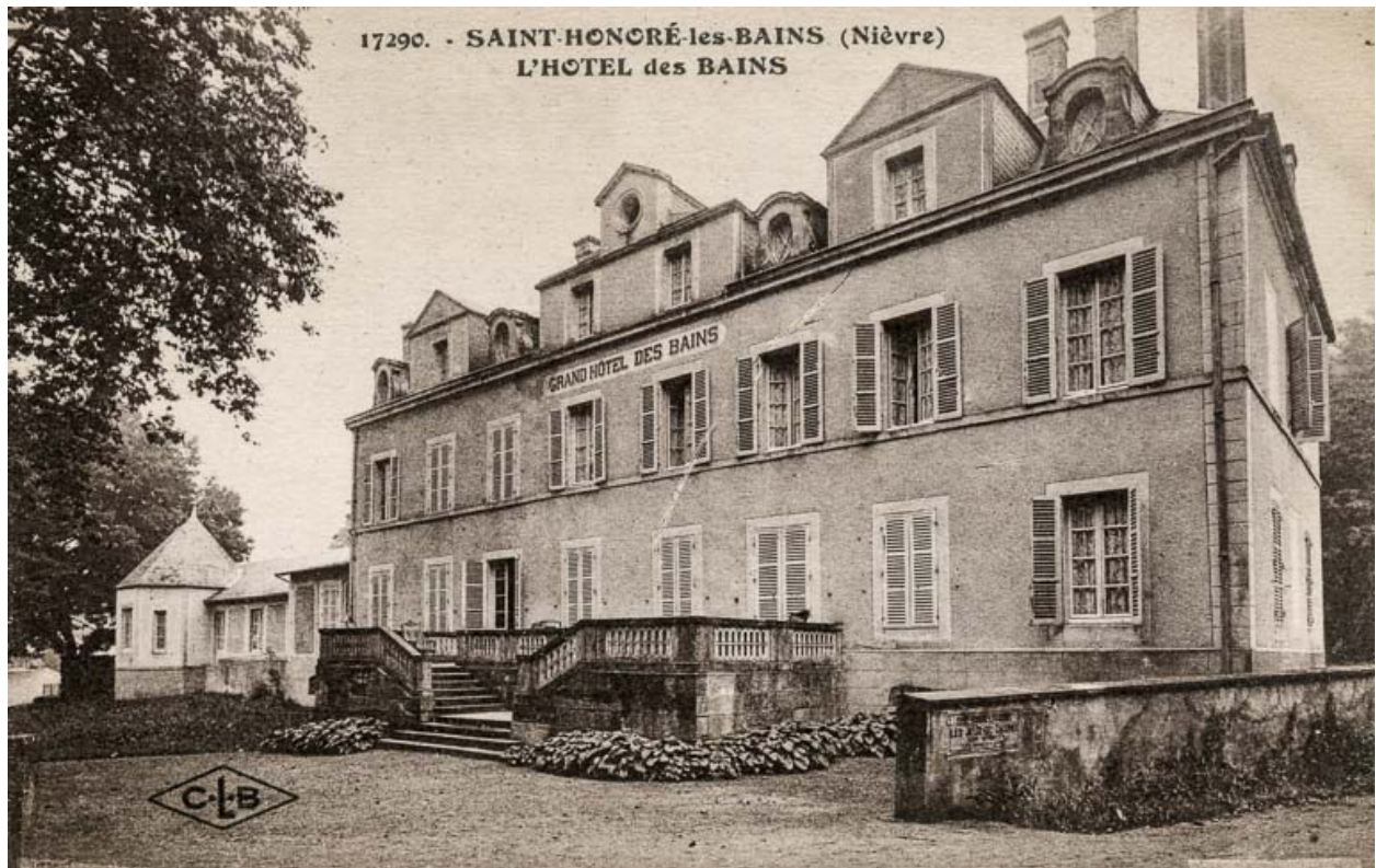
Façade principale, vue depuis le sud-ouest.
