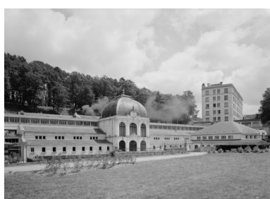
Vue d'ensemble depuis le nord- ouest à la fin des années 1970. Phot. Jean-Luc Duthu IVR26_19775800595V
