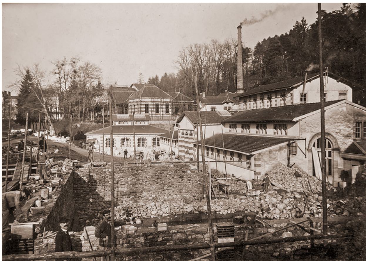
Construction du pavillon de la piscine.
