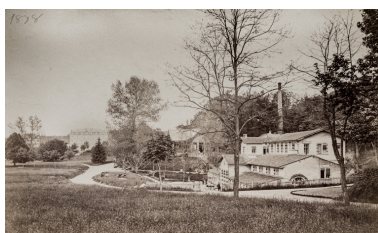
Façade principale, état en 1878. Repro. Pierre-Marie Barbe- Richaud, Autr. auteur inconnu IVR26_20195800299NUC4A
