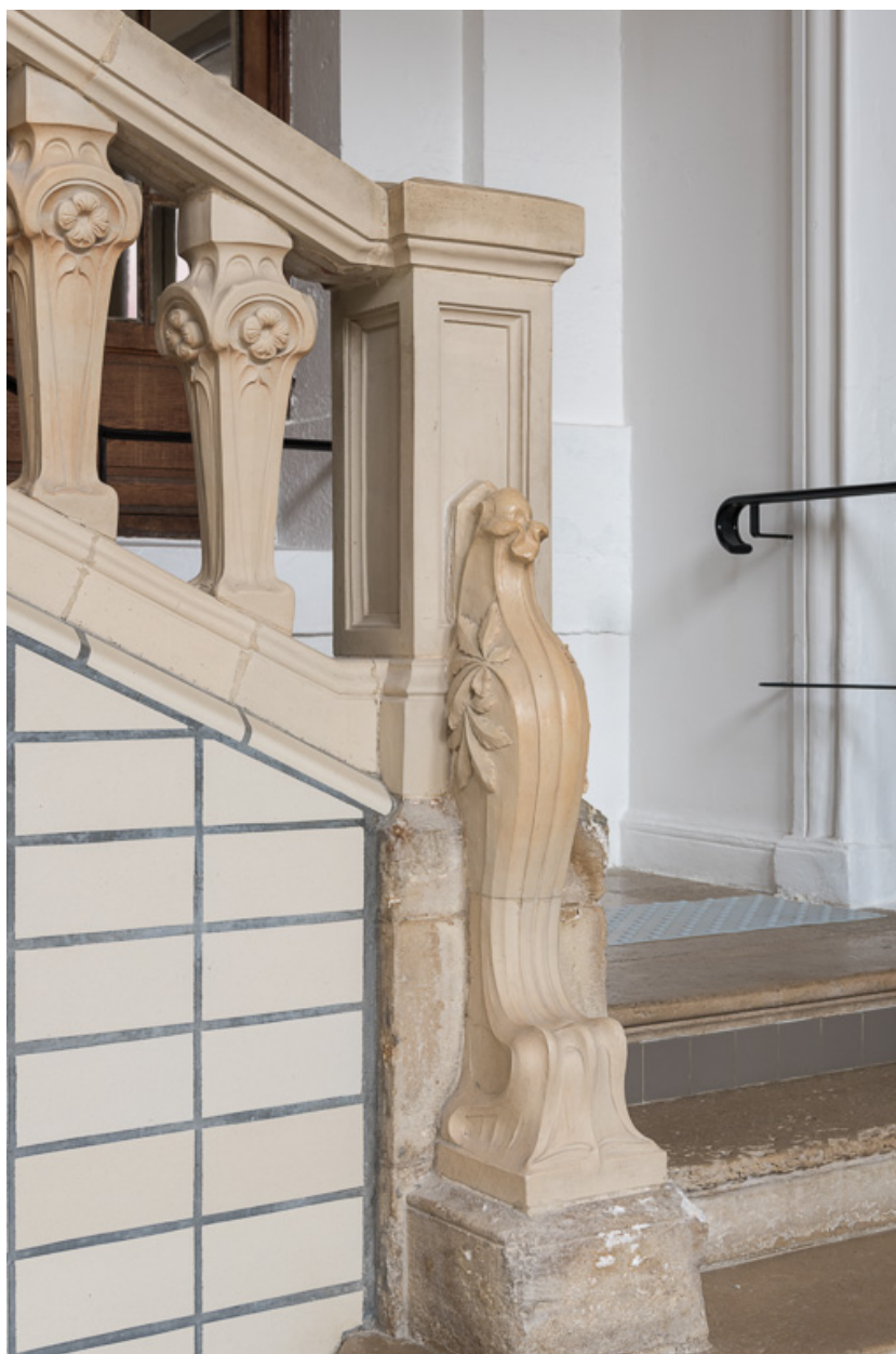
Hall des sources, rampe du degré, détail.
