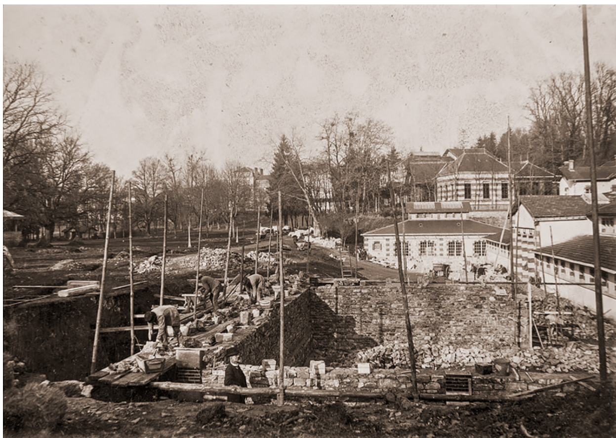
Construction du pavillon de la piscine.
