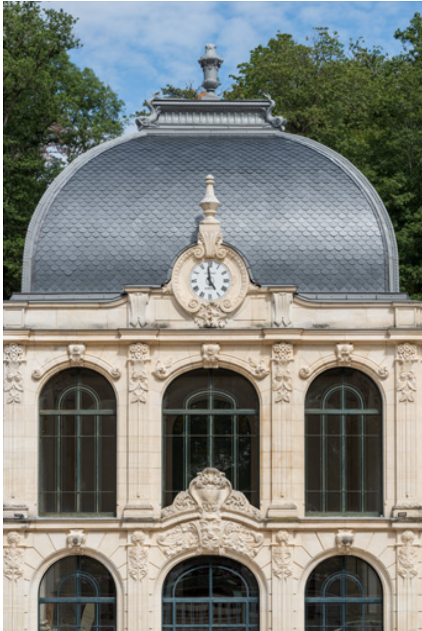
Pavillon central, vue de face, détail.
