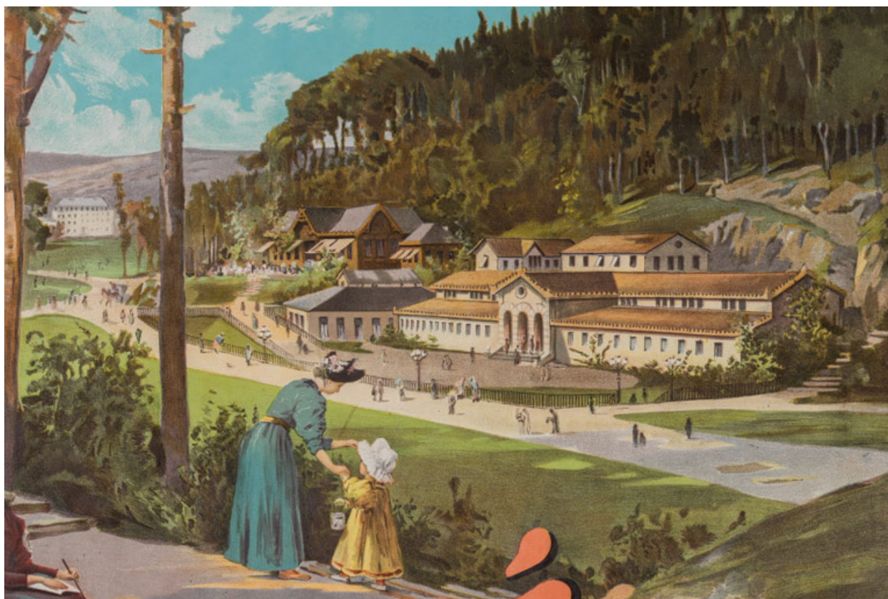
Façade principale, fin du 19e siècle.
