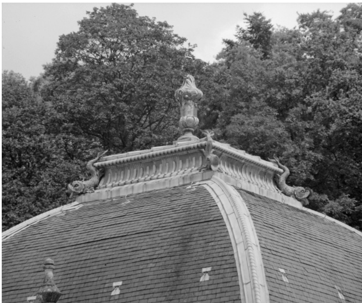
Pavillon central, détail de la couverture.
