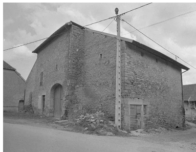
Façade sur rue. Phot. Dominique Dominguez IVR43_19783900154X
