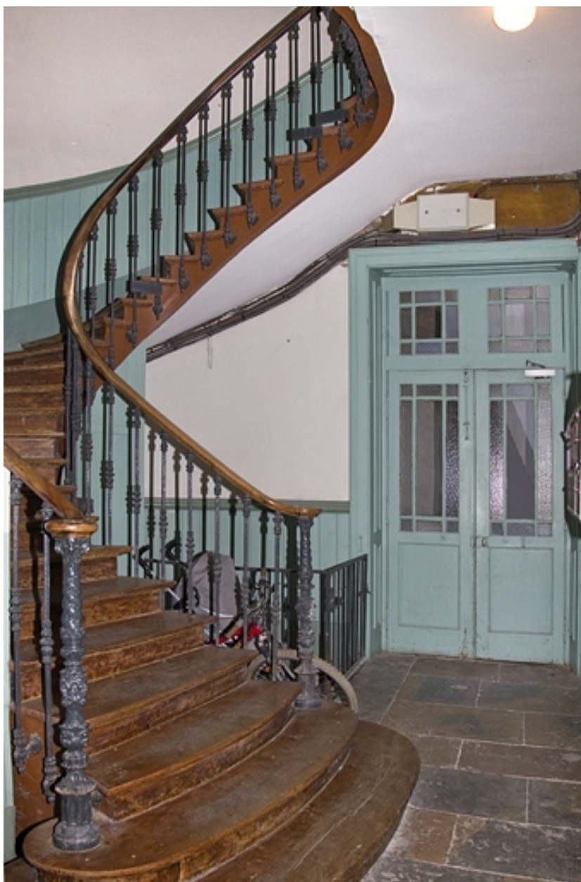
Intérieur : vue d'ensemble de l'escalier.
