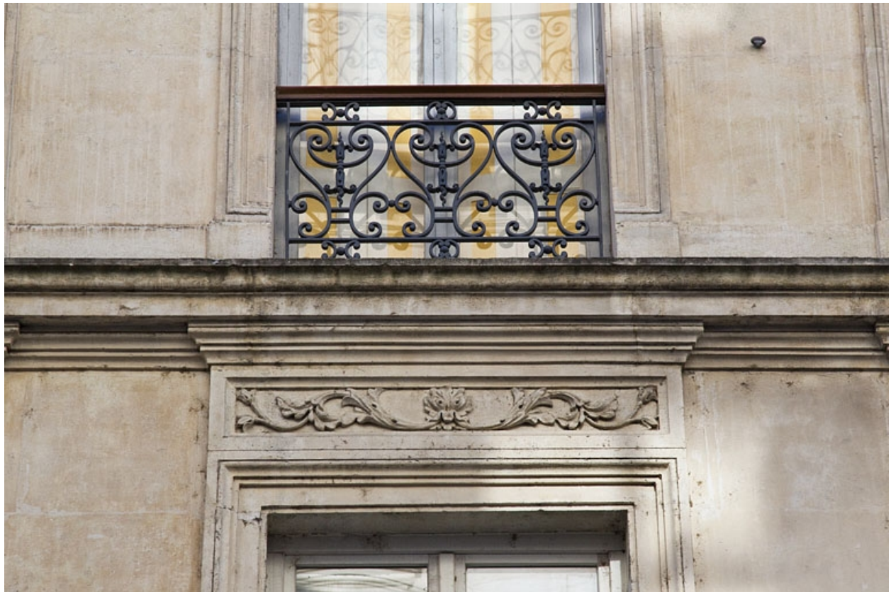
Façade antérieure : détail d'un garde-corps d'une fenêtre.
