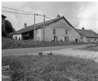
Ferme située Grande Rue. Phot. Yves Sancey IVR43_19802501134X
