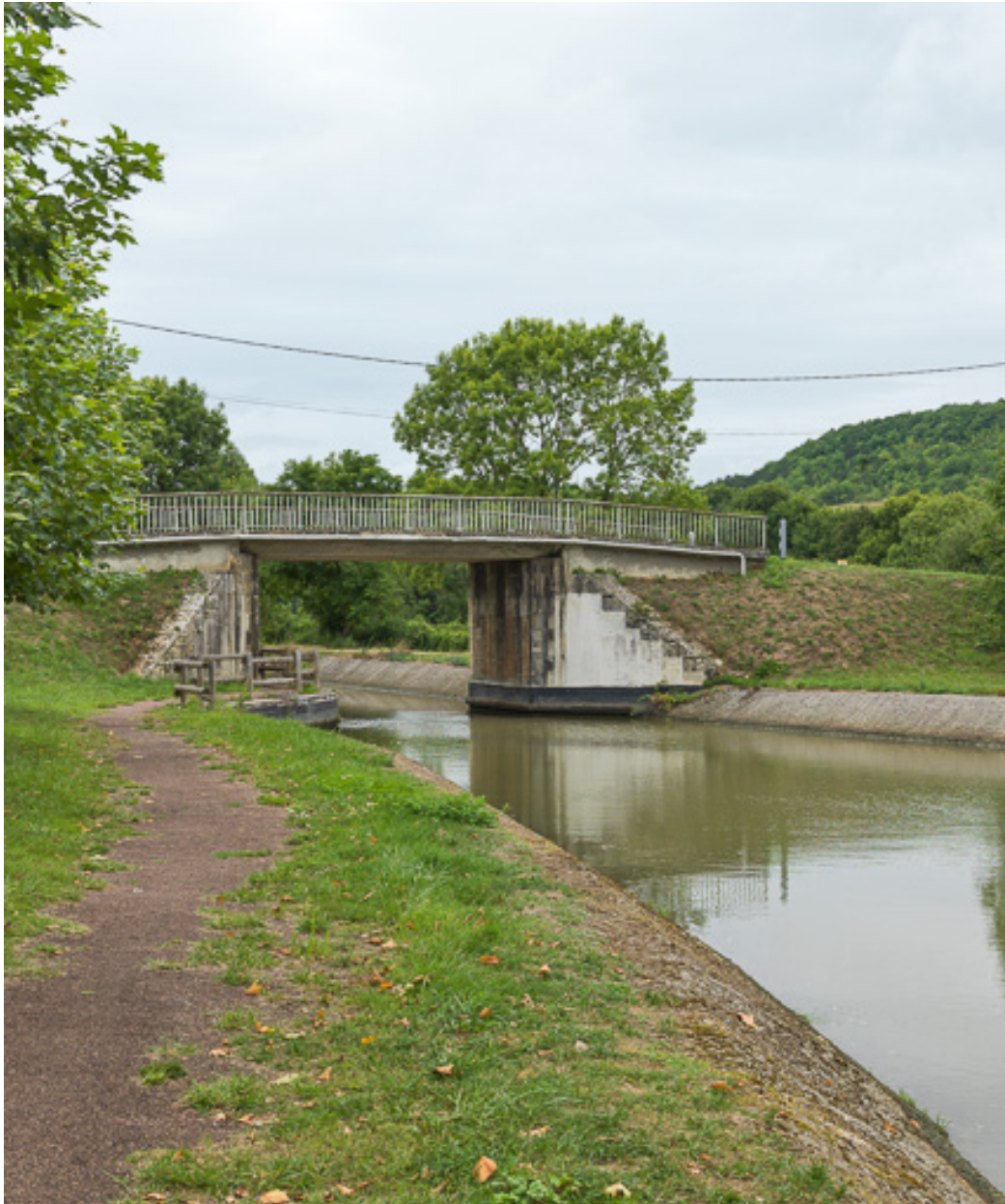
Vue d'ensemble du pont.
