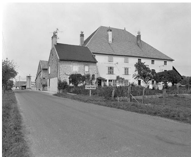
Vue d'ensemble depuis la RN 492. Phot. Yves Sancey IVR43_19802500870X
