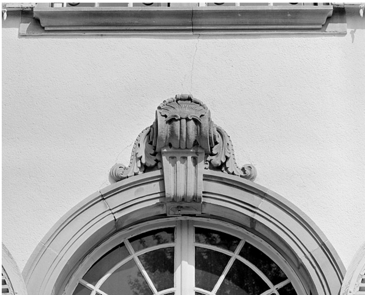
Façade sud. Détail d'une fenêtre du rez-de-chaussée.
