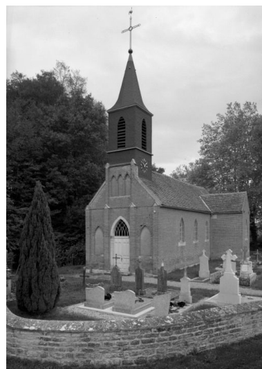
Elévations antérieure et droite Phot. Jean-Luc Duthu IVR26_19862101061V
