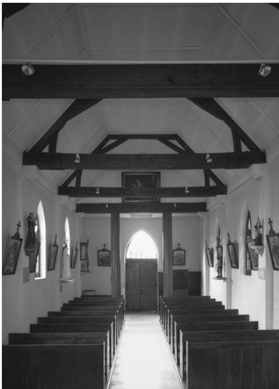
Vue intérieure prise du chœur
