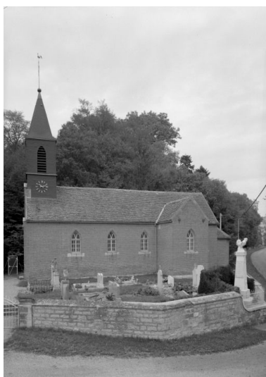
Elévation droite Phot. Jean-Luc Duthu IVR26_19862101062V
